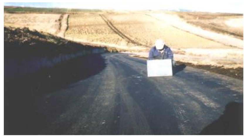
下層、上層路盤及びAS舗装の復旧
