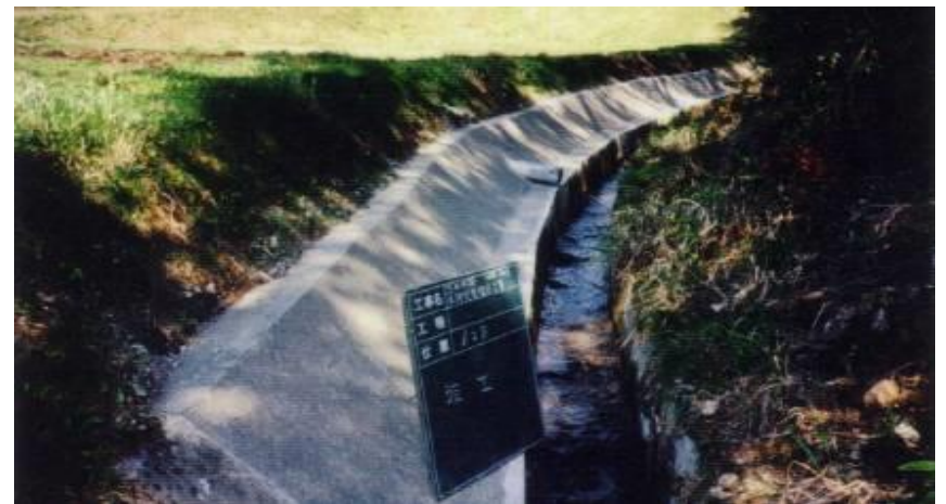
張りコンクリートで復旧
