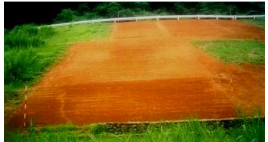
法面整形、筋芝工による復旧
