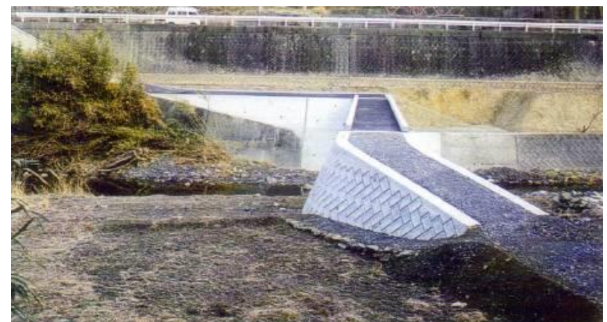
桁下高を上げて復旧
