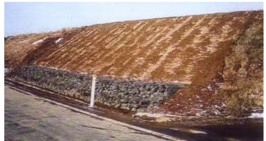
フン籠及び盛土により復旧
