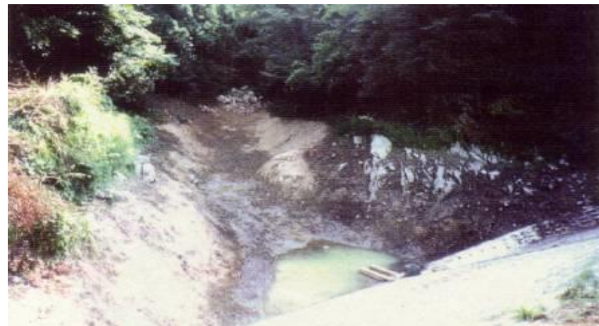
土砂排除により復旧
