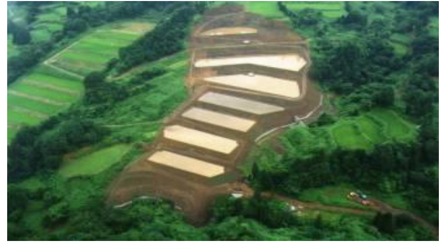
区画変更し抑え盛土、地下水排除工を新設
