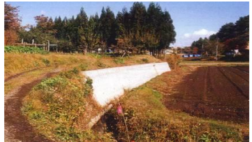
ブロック積による復旧
