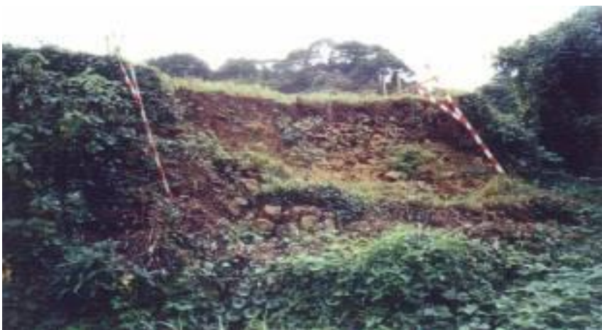
豪雨により畦畔崩壊
