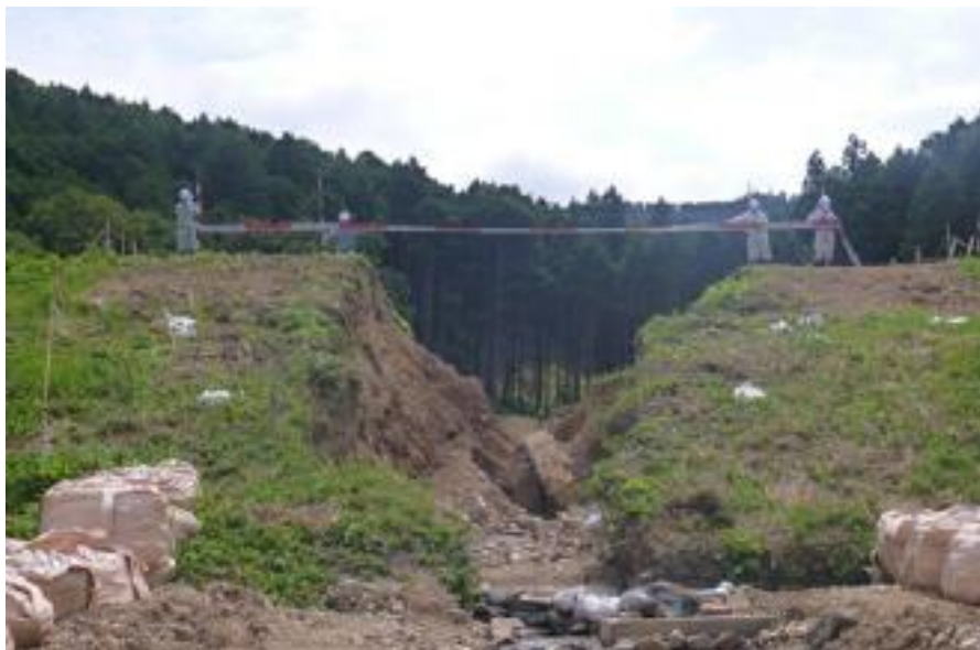
ため池の決壊(6月 梅雨前線 愛媛県西条市)
