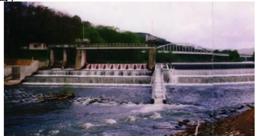
副堤及び魚道を設置し、機能を回復
