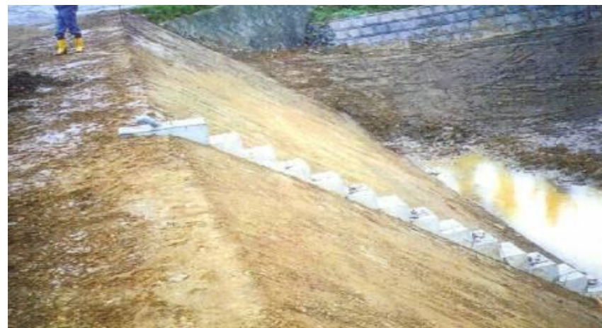
斜樋、底樋を復旧
