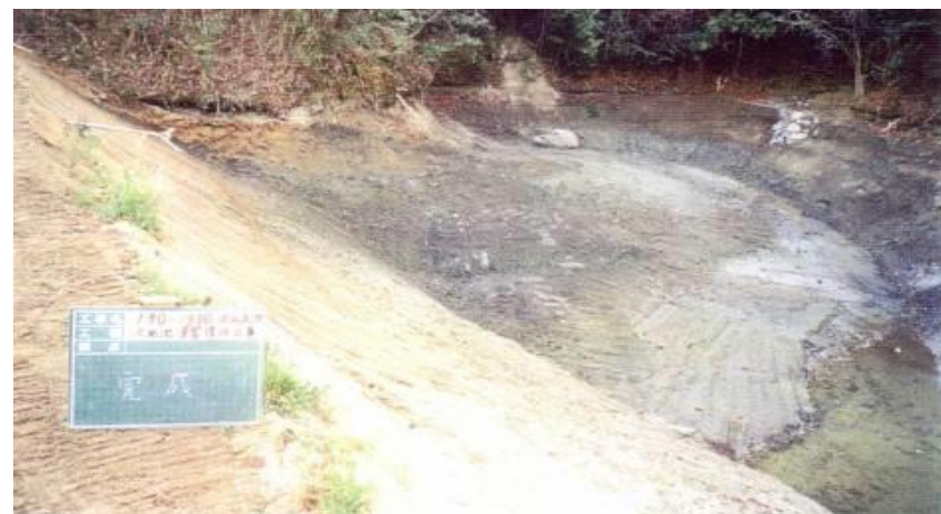
土砂及び流木排除より復旧
