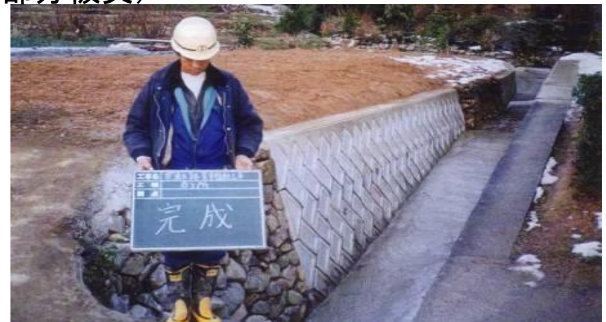
ブロック積で復旧
