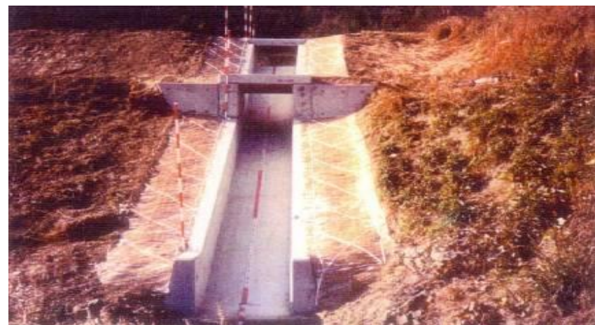
現場打ちにより復旧
