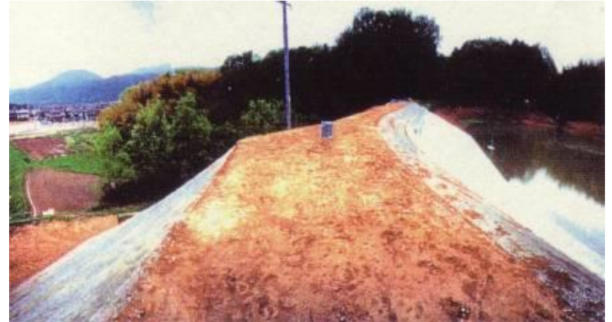
堤体を築直し、波徐護岸を新設
