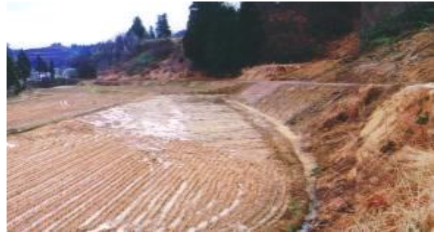
土砂排除による復旧
