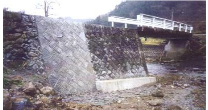
ブロック積による復旧
