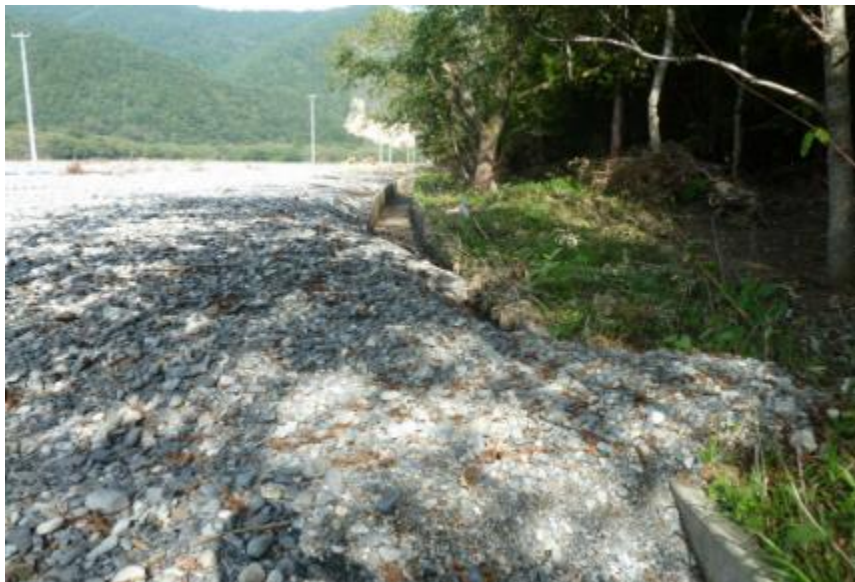
農道と水路への土砂堆積(8月 台風10号 岩手県岩泉町)
