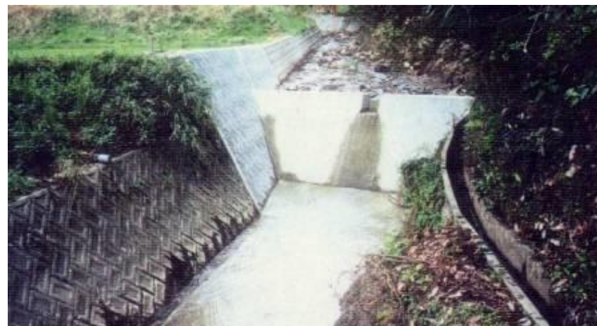
コンクリート堰にて復旧
