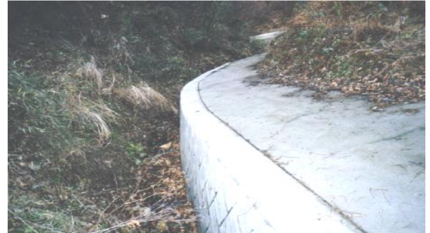
ブロック積による法留め工で復旧
