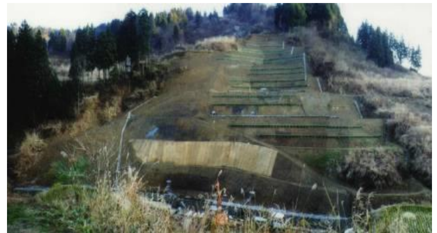
区画を変更しフトン籠、鋼管杭を新設
