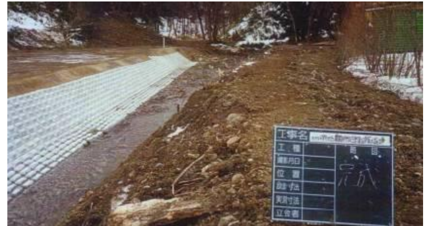
連結ブロックにより復旧
