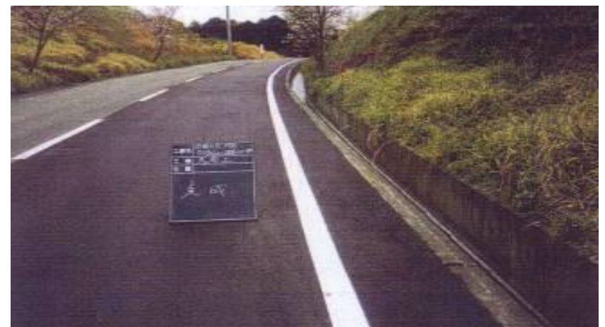
路盤及びAS舗装による復旧
