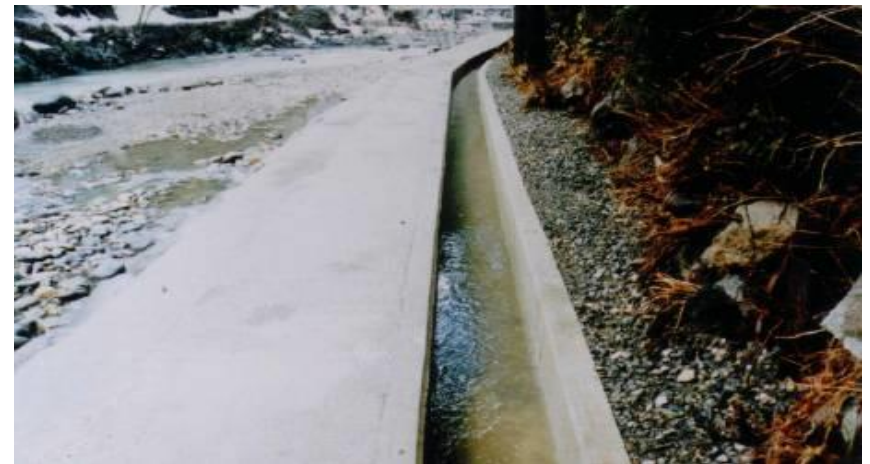
現場打ちコンクリートにより復旧
