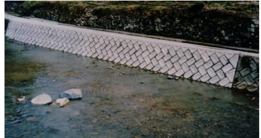
水路及びブロック積で復旧
