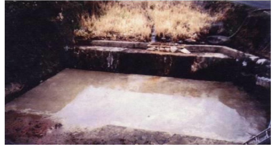
水叩き部をコンクリートにて復旧
