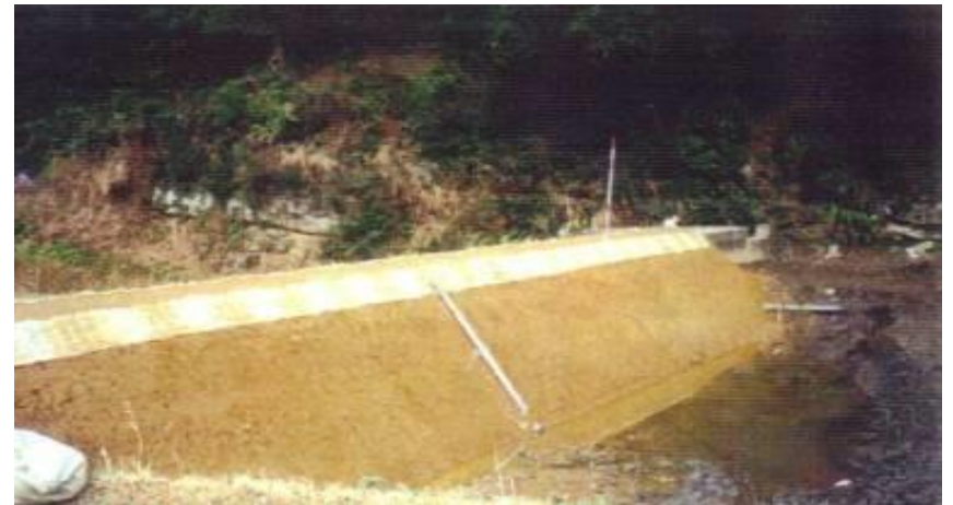
空洞部を開削し、前刃金工で復旧
