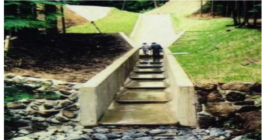
現場打ち水路、減勢工にて復旧
