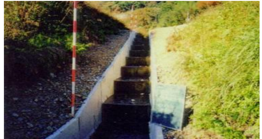
コンクリートフリーフォーム水路により復旧
