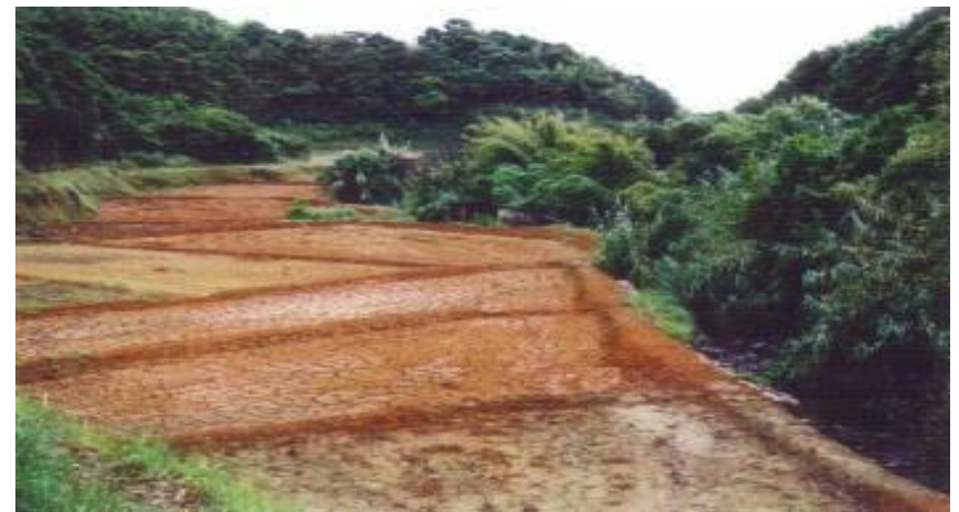
土砂排除及び表土搬入による復旧
