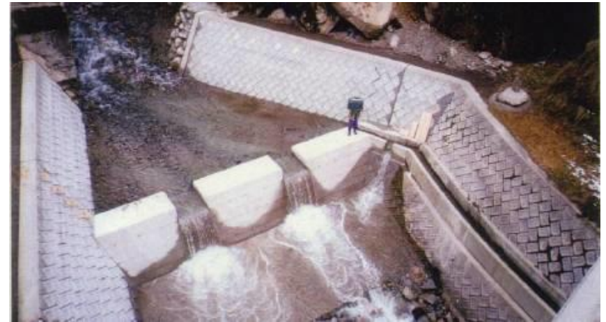
堤体、水叩き、護岸工を復旧
