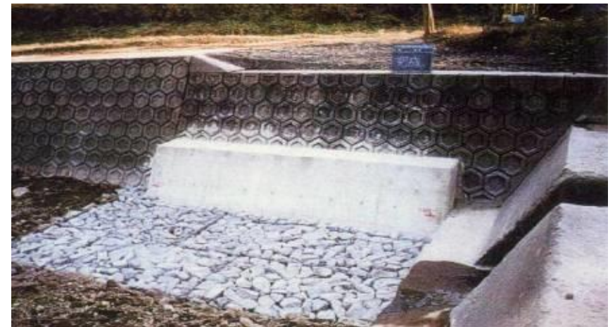
ブロック基礎を根継工にて復旧
