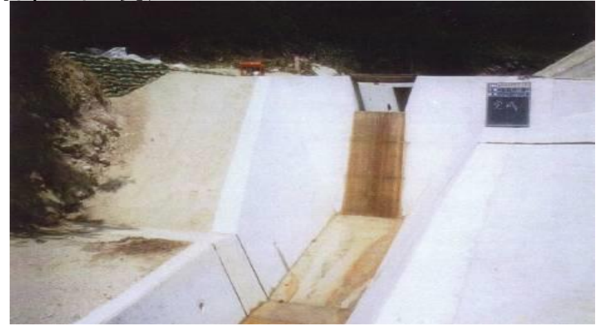
水位上昇に見合う護岸工等の復旧
