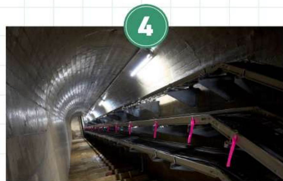
4 監査廊 ダムの堤体内部にある、ひび割れや漏水などの異常の有無の観察・測定などの点検を行う管理用通路
