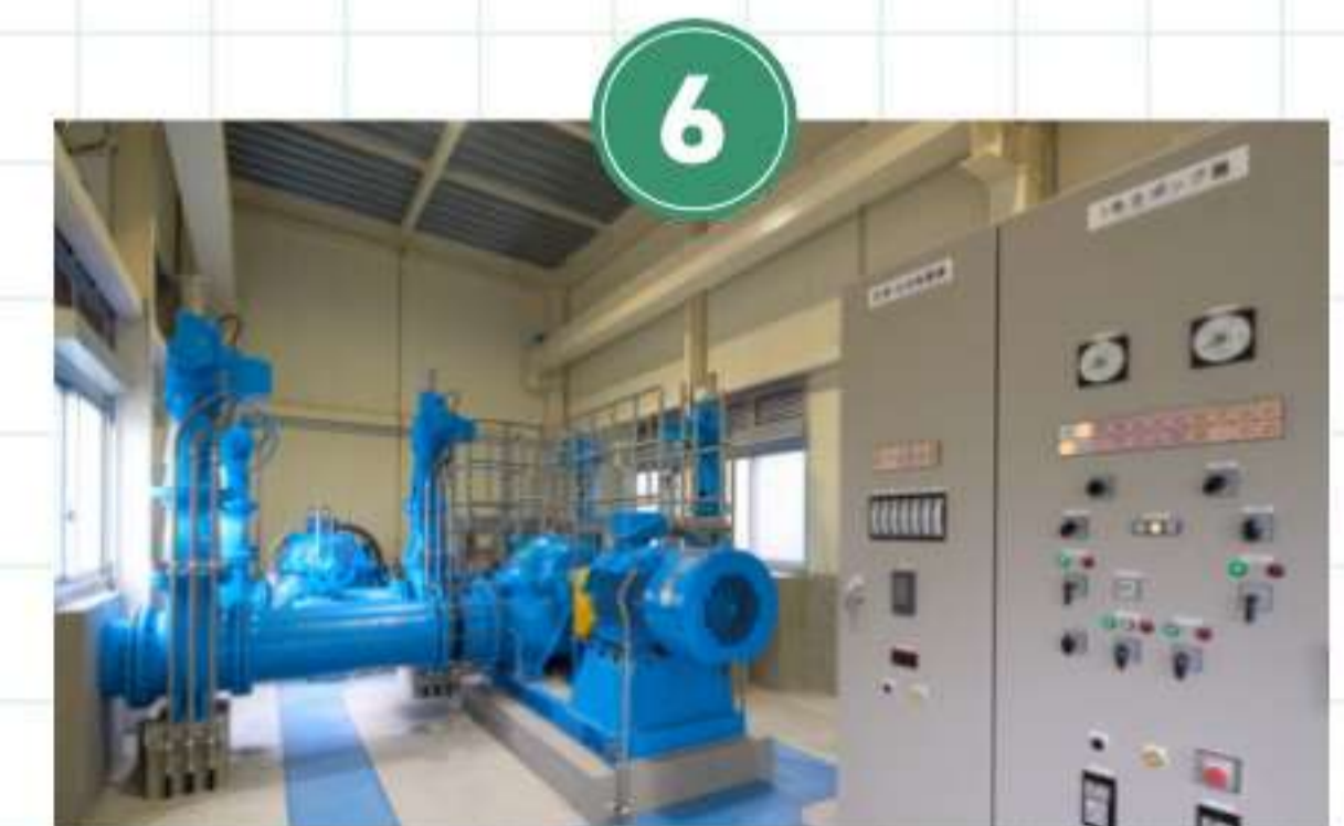
6 吞吐揚水機場 吞吐ダムの水を山田幹線水路に補給するためのポンプ場（東播用水二期事業で建設）
