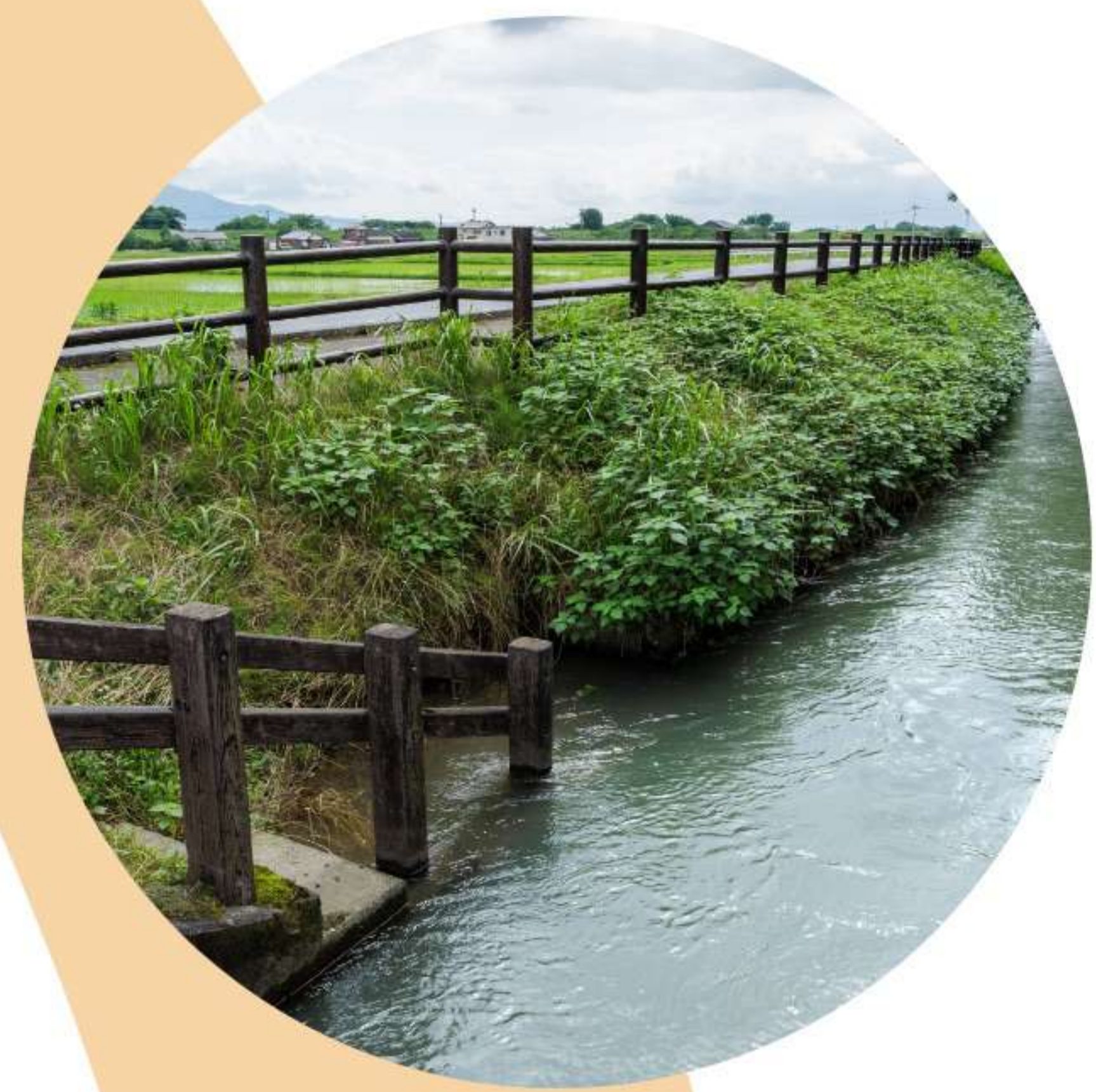
堀川用水。開削時の全長は約8キロメートルでしたが、その後幅延長を重ね、今では支線まで合わせると合計88キロメートルに達します。
