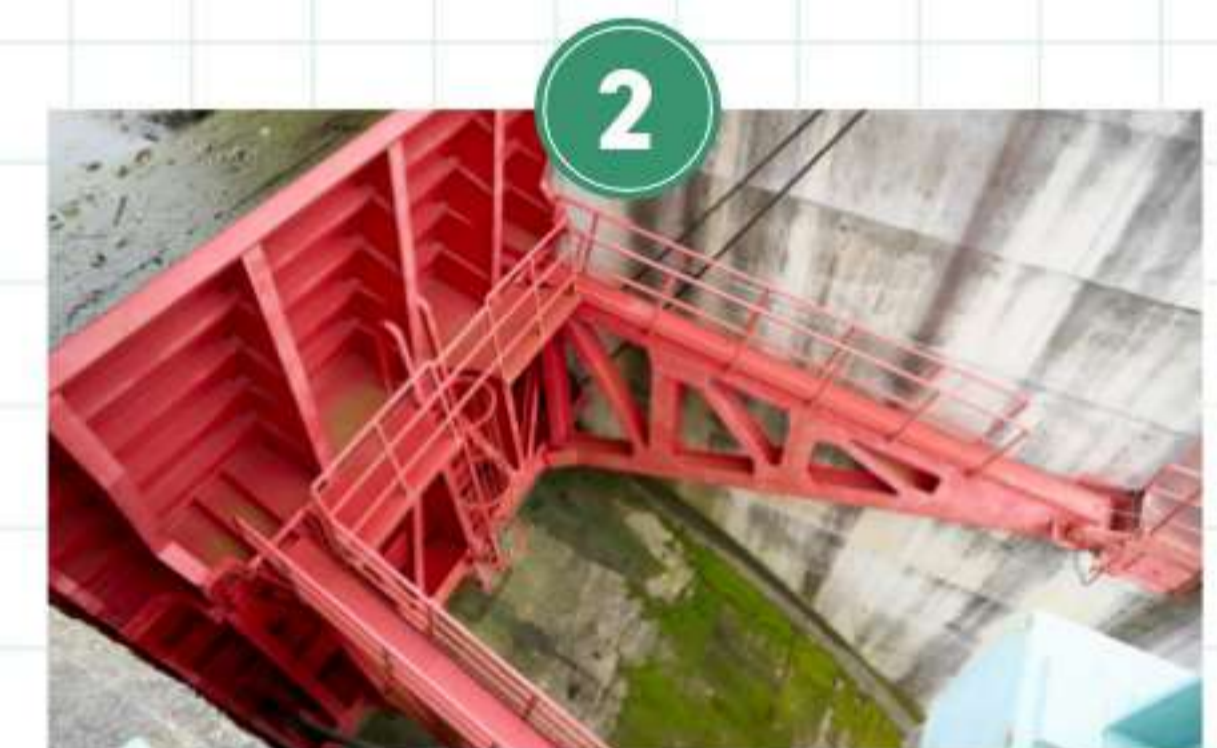
2 洪水吐ゲート 大雨の際、最大で1秒間に925立方メートルの水を放流する能力がある
