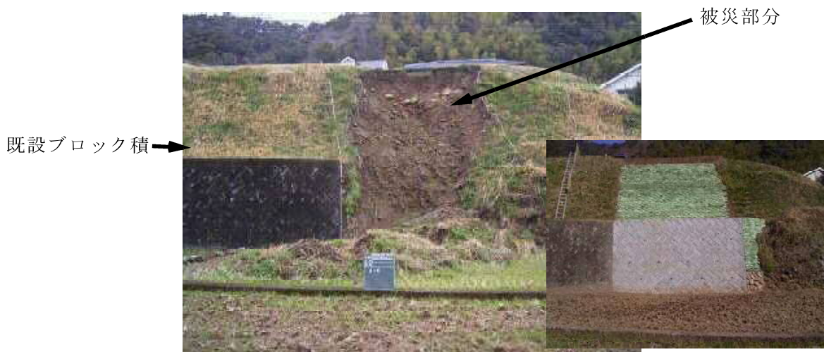
写真：既設構造物がある場合の例
