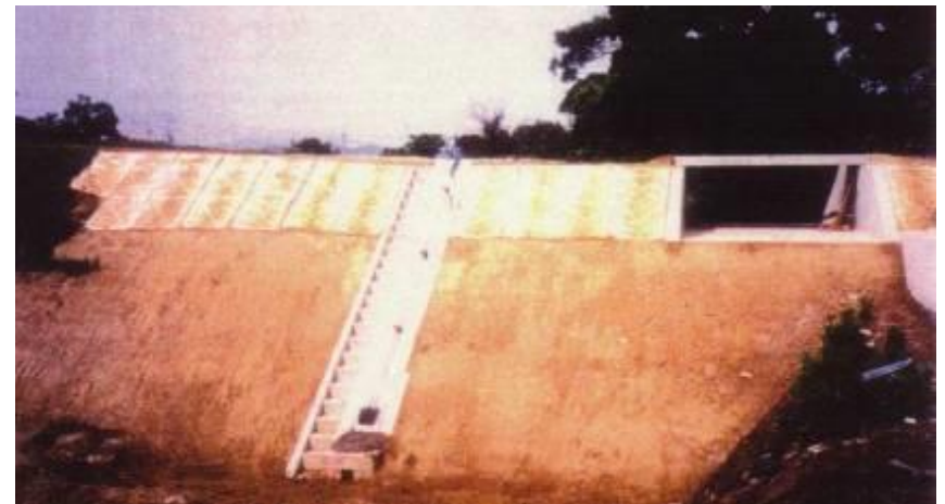
現場打ちコンクリートにより復旧
