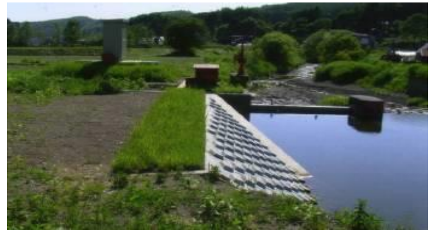
操作ユニットの復旧及び護岸の施工
