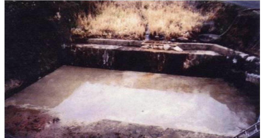
水叩き部をコンクリートにて復旧
