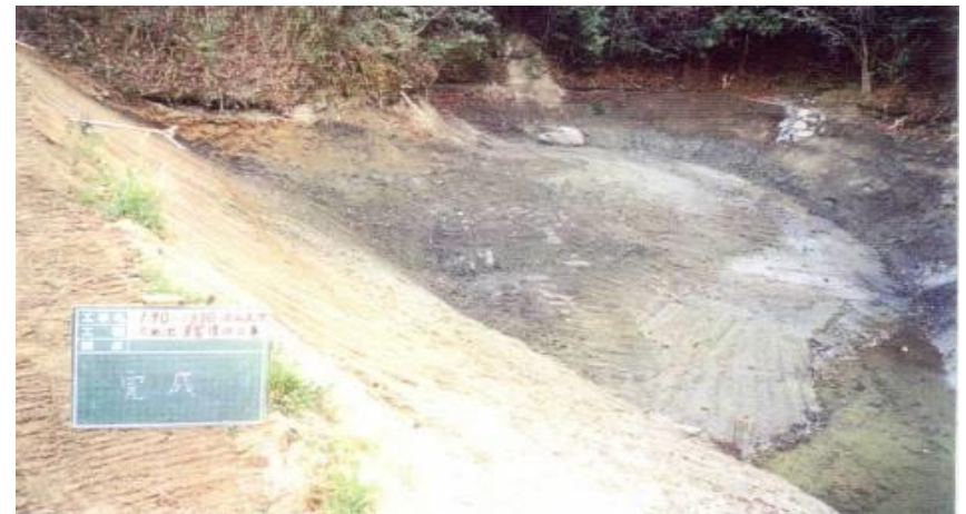
土砂及び流木排除より復旧
