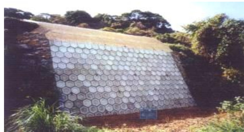
ブロックによる復旧
