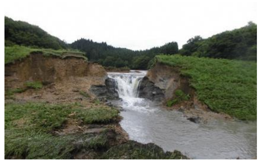
ため池の被災(7月 梅雨前線 秋田県大仙市)
