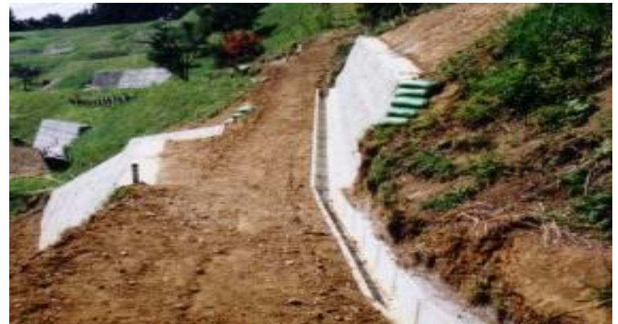
ブロック積による復旧
