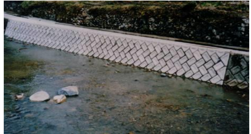
水路及びブロック積で復旧
