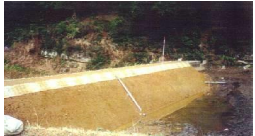
空洞部を開削し、前刃金工で復旧
