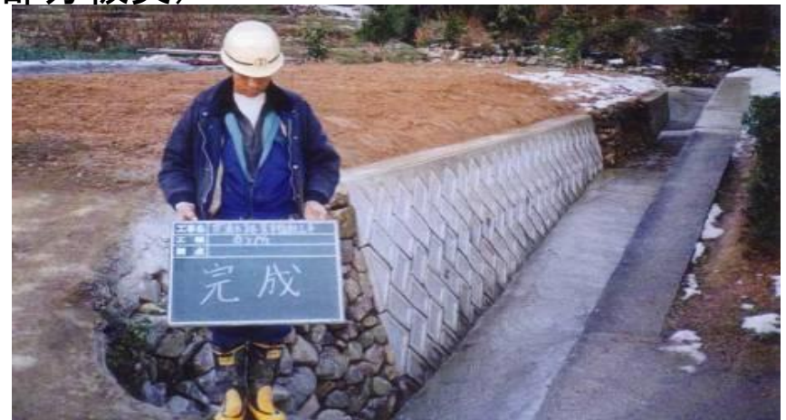
ブロック積で復旧
