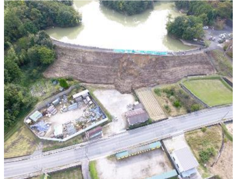
ため池の被災(10月 台風21号 奈良県葛城市)
