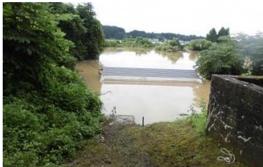
揚水機場の被災(7月 梅雨前線 秋田県大仙市)
