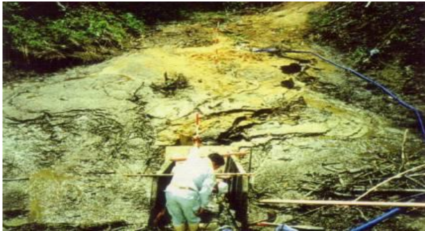
豪雨により土砂が流入
