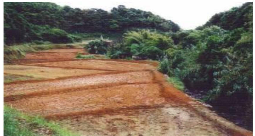
土砂排除及び表土搬入による復旧
