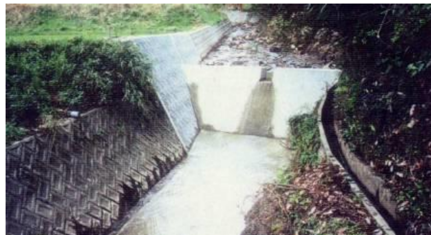
コンクリート堰にて復旧
