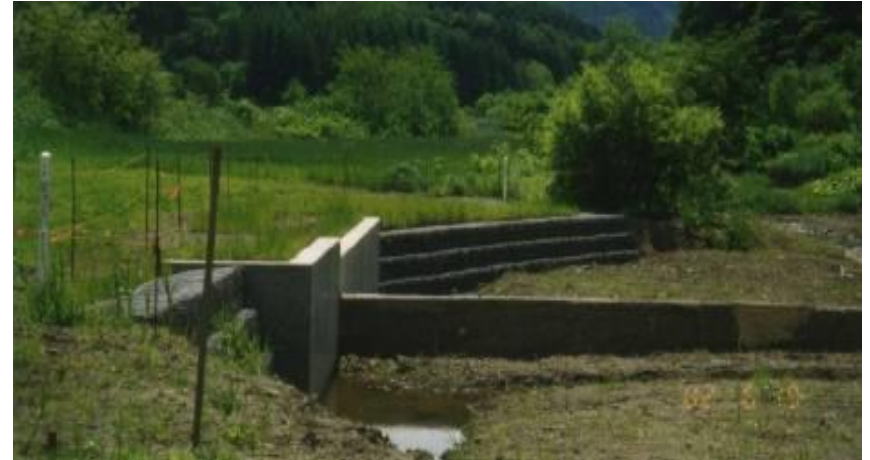
コンクリート擁壁及び取付護岸を復旧
