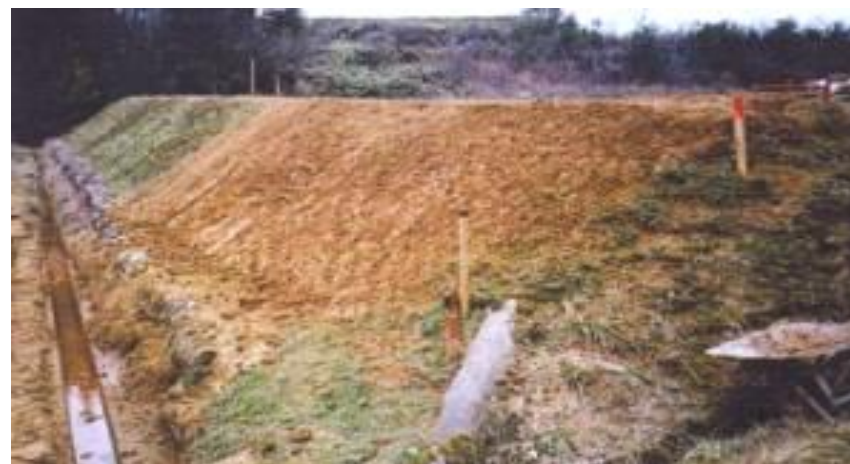
土羽による畦畔の復旧 (既存フン籠利用)
