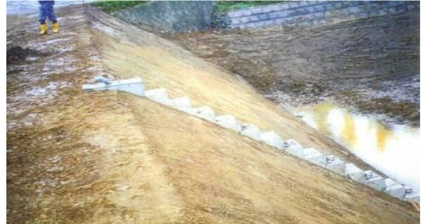
斜樋、底樋を復旧
