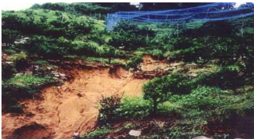
異常出水により農地が被災
