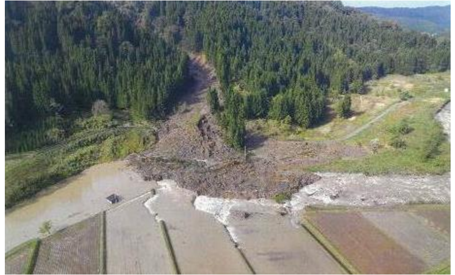
頭首工の被災(10月 台風21号 新潟県糸魚川市)
