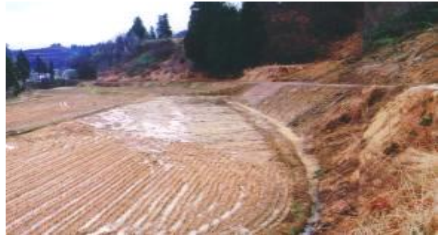
土砂排除による復旧
