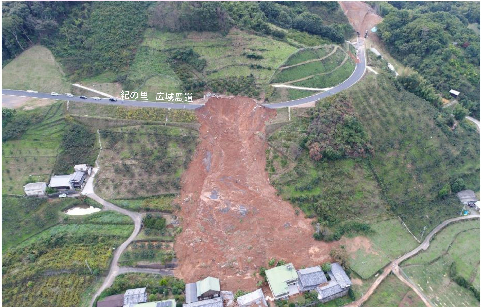
農道と農地の被災(10月 台風21号 和歌山県紀の川市)
