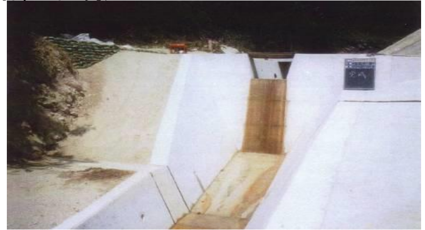
水位上昇に見合う護岸工等の復旧
