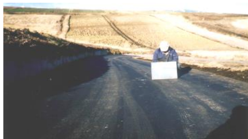
下層、上層路盤及びAS舗装の復旧
