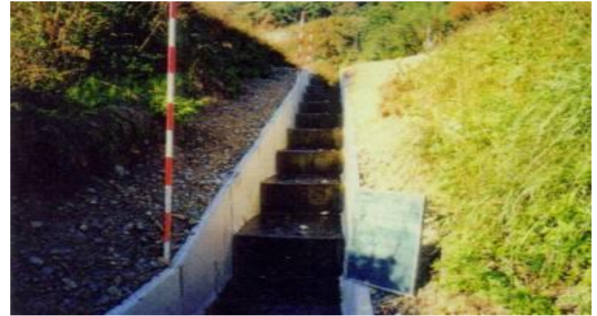
コンクリートフリーム水路により復旧
