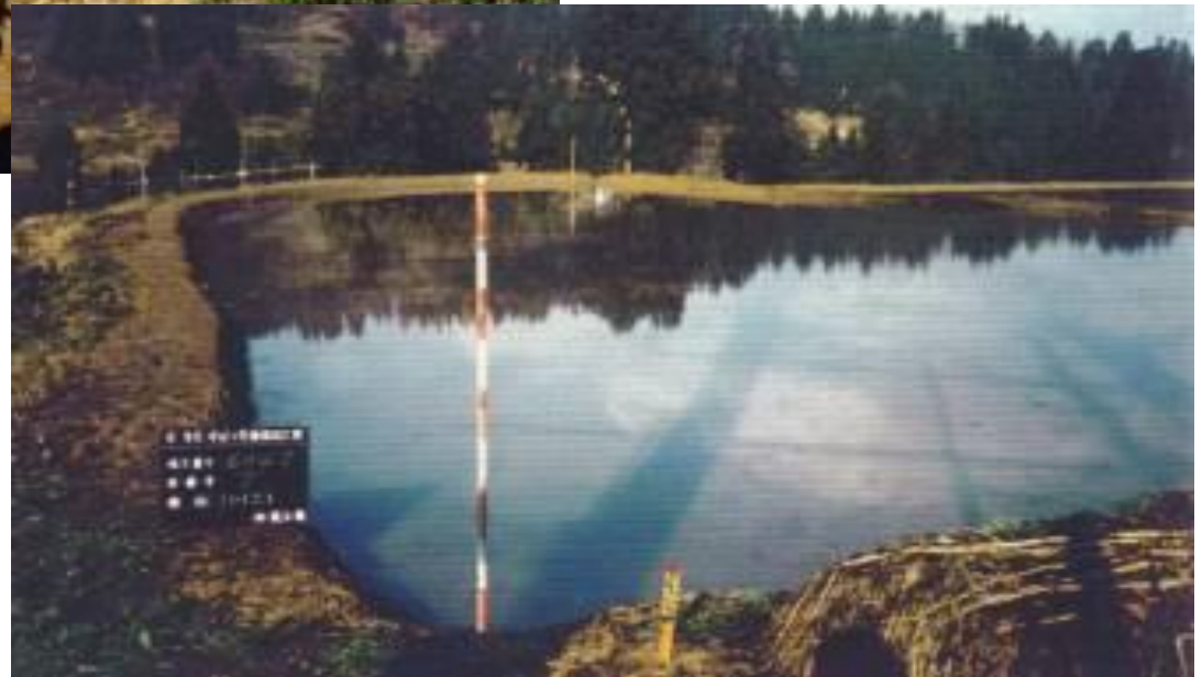
心土練り直し、転圧、水整地により復旧
