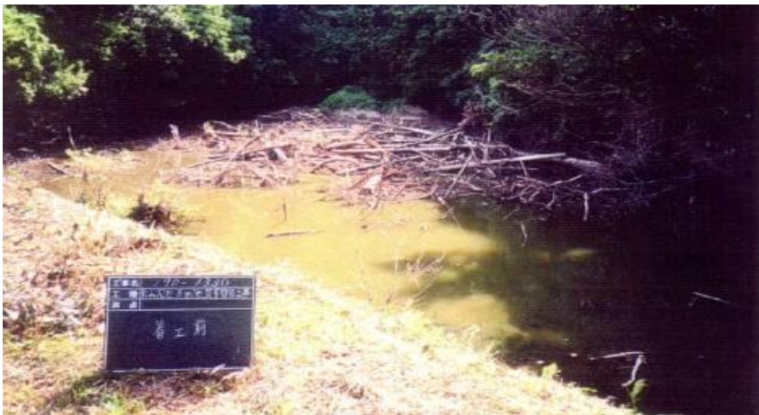
豪雨により土砂及び流木が流入
