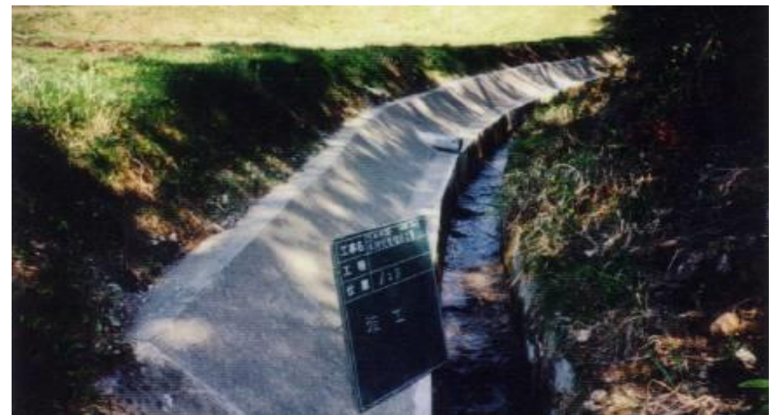
張りコンクリートで復旧
