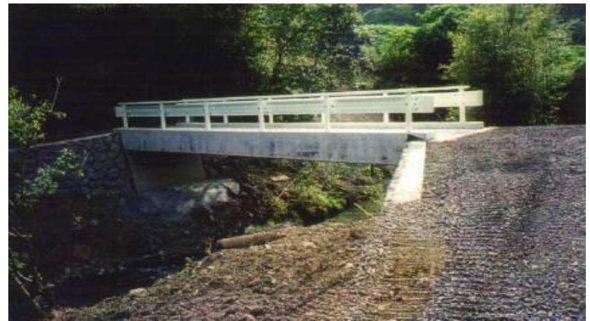
当該被害洪水を対象として復旧
