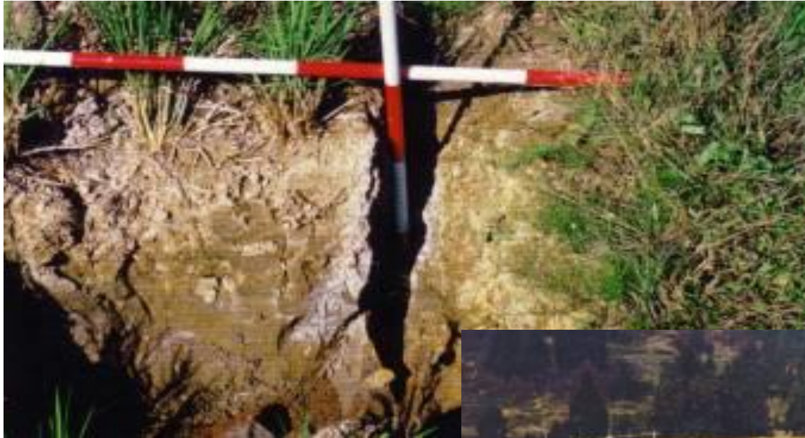
干ばつにより亀裂発生
