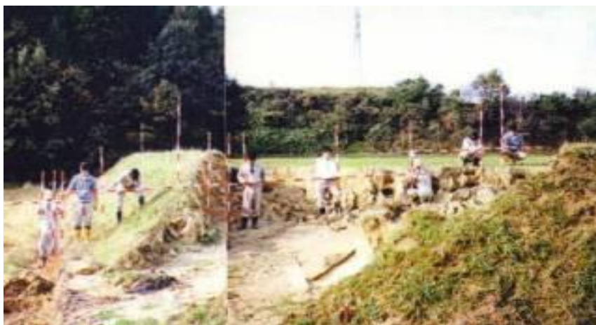
豪雨により畦畔崩壊
