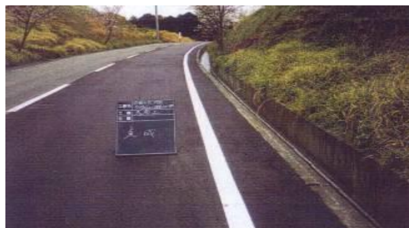
路盤及びAS舗装による復旧
