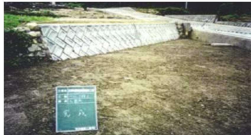
ブロックによる復旧
