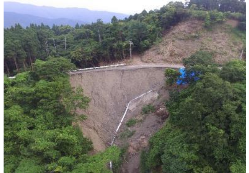
農道の被災(4月 豪雨災害 宮崎県日南市)
