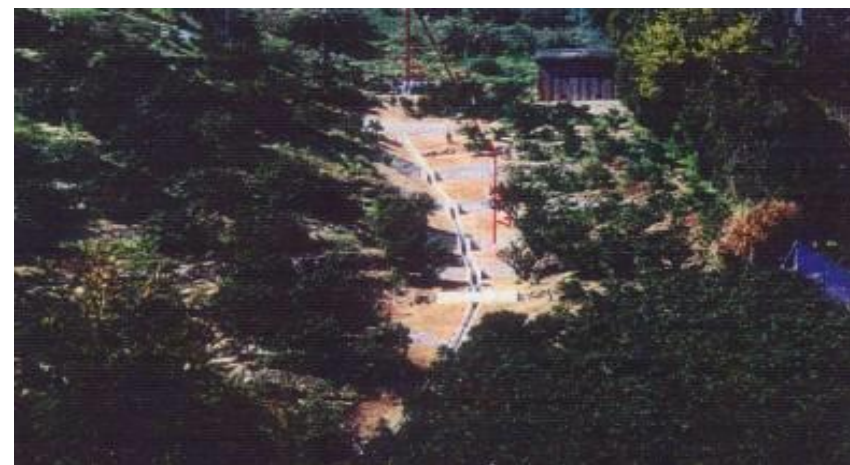
土止め、承水路工の新設
