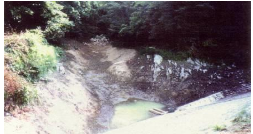
土砂排除により復旧
