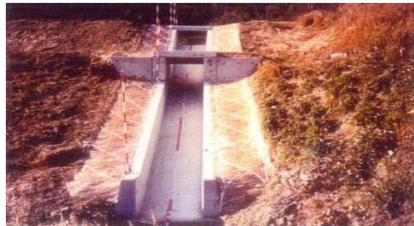
現場打ちにより復旧
