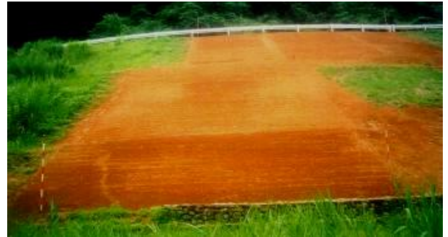
法面整形、筋芝工による復旧
