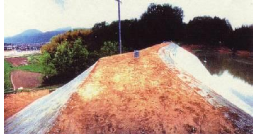
堤体を築直し、波徐護岸を新設
