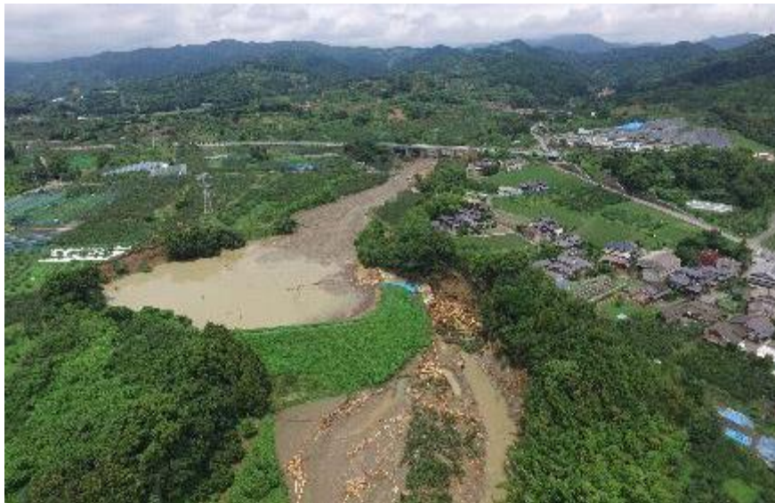
ため池の被災(7月 梅雨前線 福岡県朝倉市)
