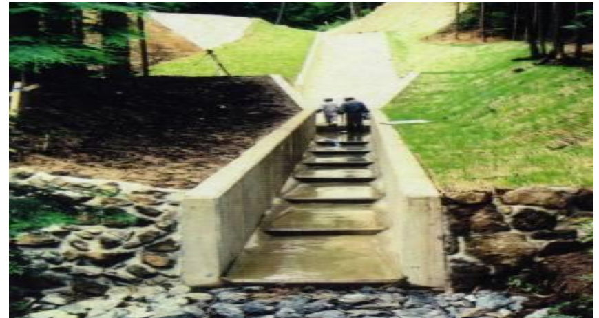
現場打ち水路、減勢工にて復旧
