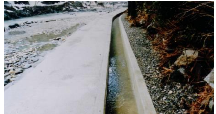
現場打ちコンクリートにより復旧
