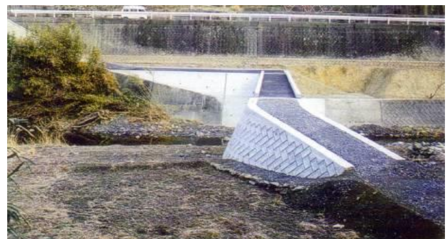
桁下高を上げて復旧
