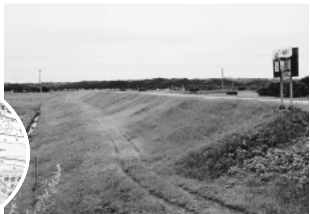
▲現在の堤防の様子
