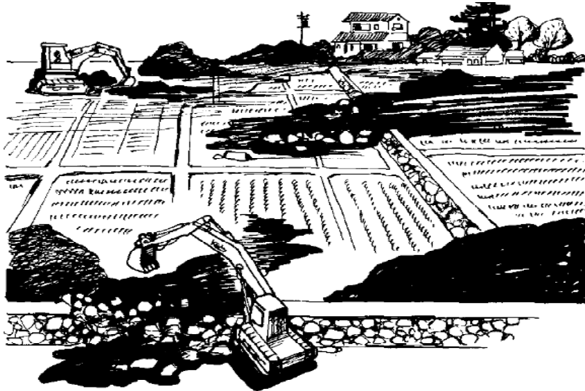
応急本工事の事例
