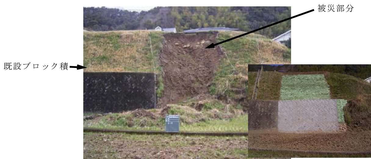
写真：既設構造物がある場合の例
