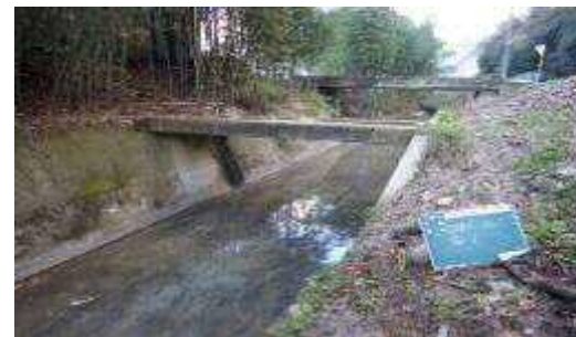
査定前着工により復旧した水路
