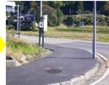
査定前着工により復旧した集落排水施設
