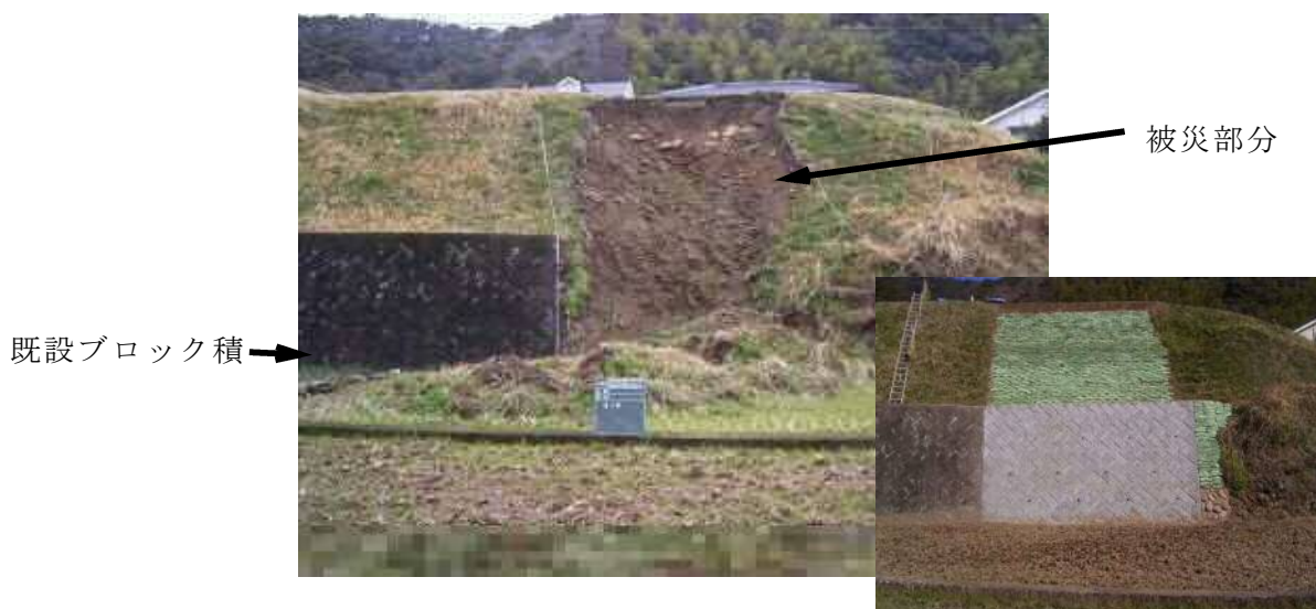
写真：既設構造物がある場合の例
