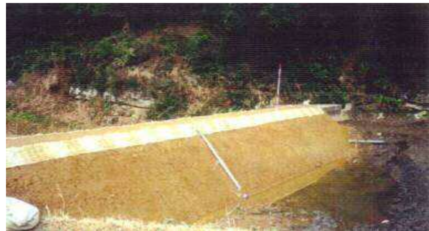
空洞部を開削し、前刃金工で復旧
