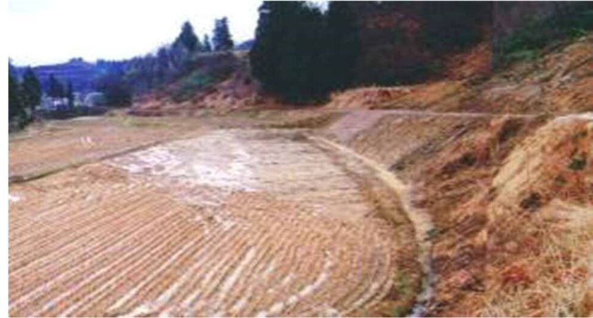
土砂排除による復旧
