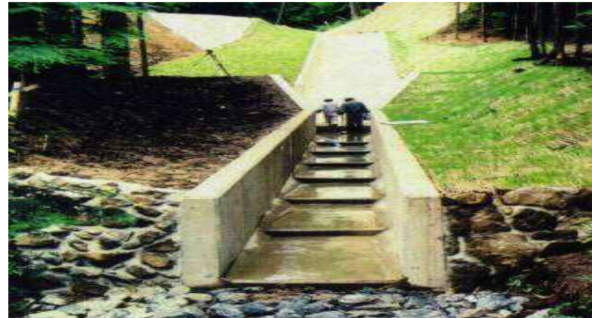
現場打ち水路、減勢工にて復旧
