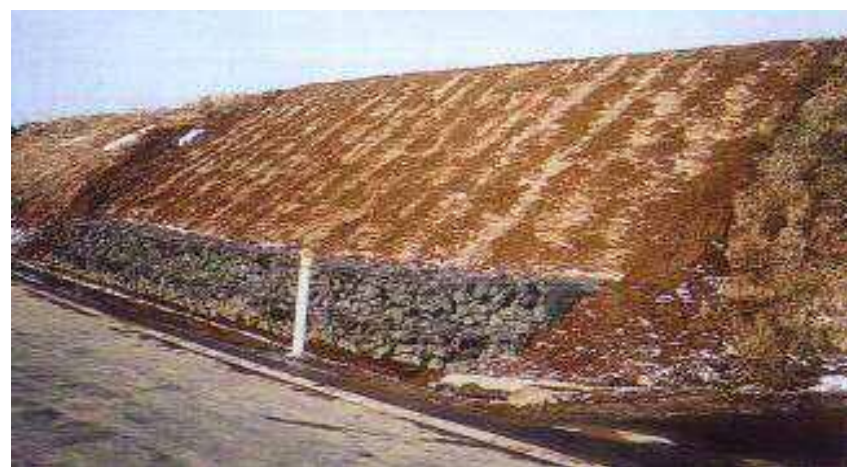
フン籠及び盛土により復旧
