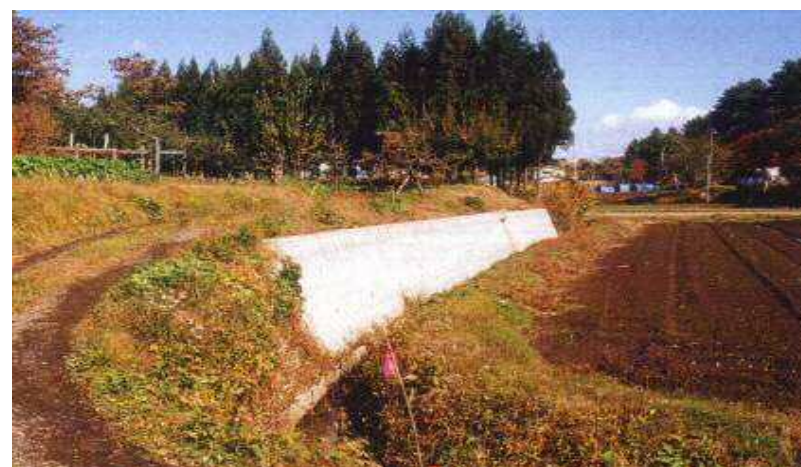
ブロック積による復旧
