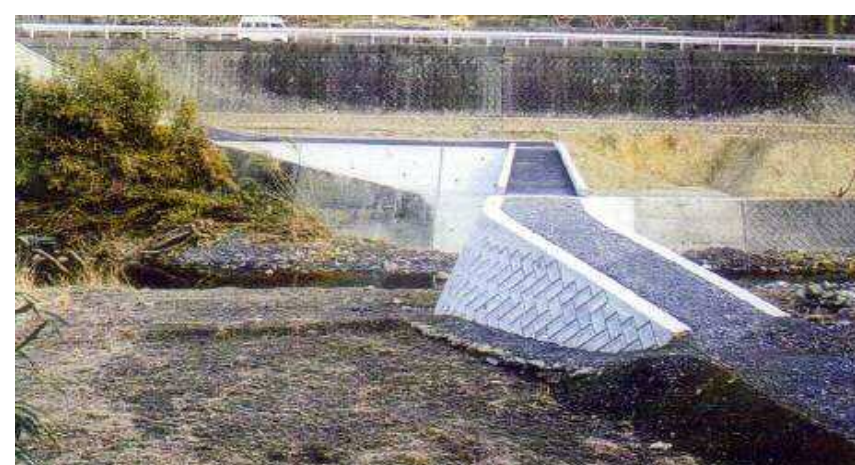
桁下高を上げて復旧
