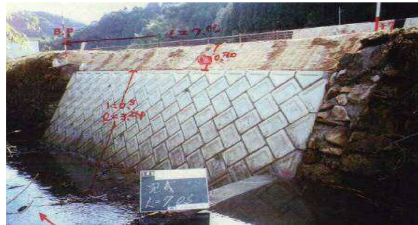
ブロック積みにより復旧
