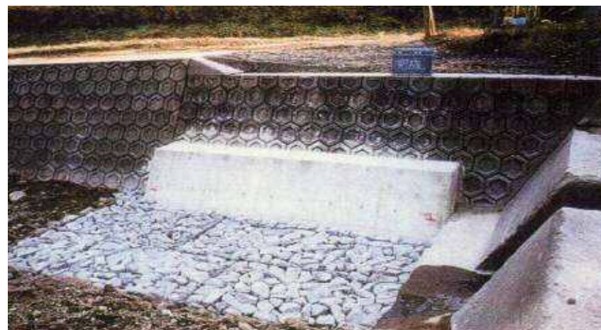
ブロック基礎を根継工にて復旧
