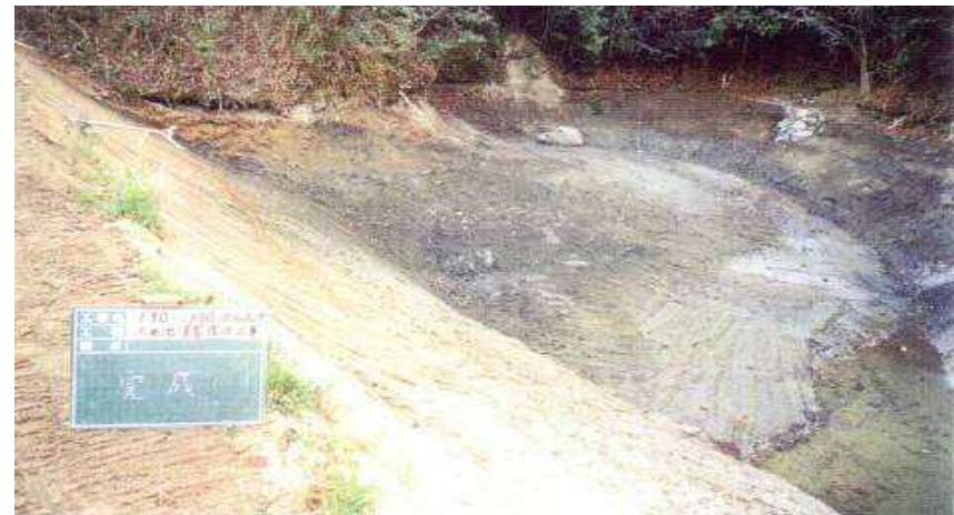
土砂及び流木排除より復旧
