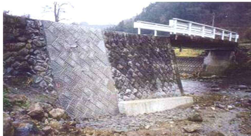
ブロック積による復旧
