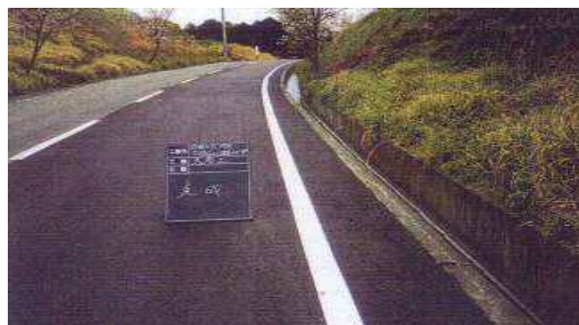
路盤及びAS舗装による復旧
