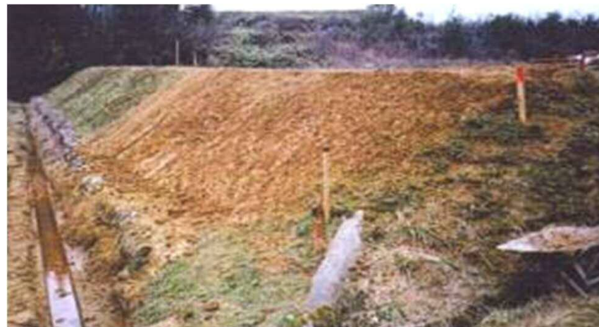
土羽による畦畔の復旧 (既存フトン籠利用)
