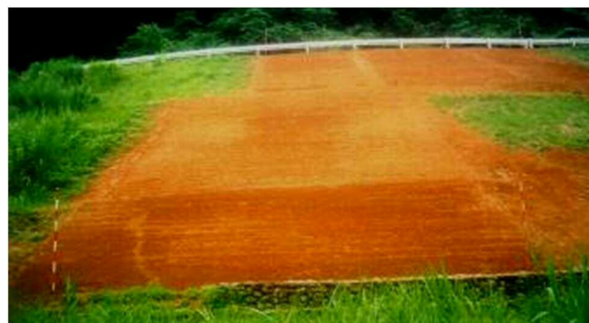
法面整形、筋芝工による復旧
