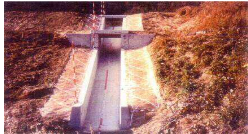
現場打ちにより復旧
