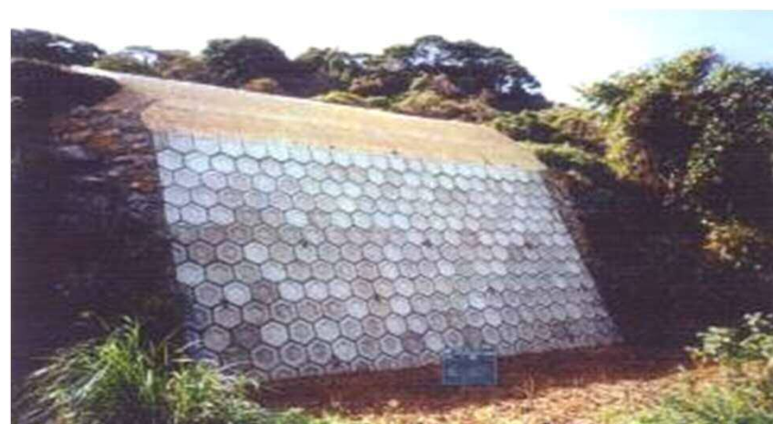
ブロックによる復旧
