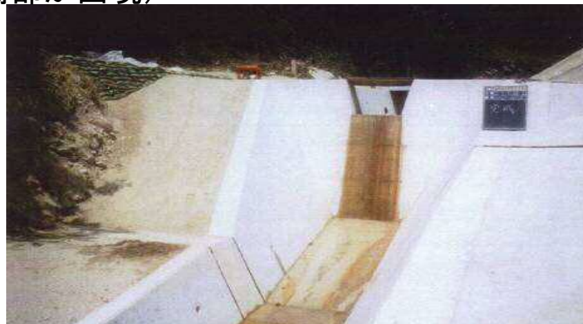
水位上昇に見合う護岸工等の復旧
