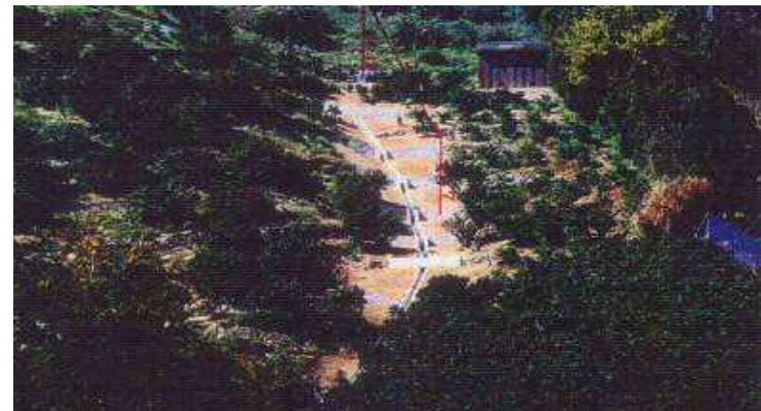
土止め、承水路工の新設
