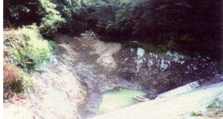
土砂排除により復旧
