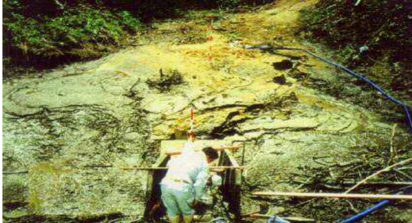
豪雨により土砂が流入
