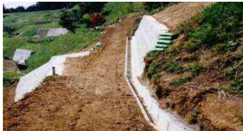
ブロック積による復旧
