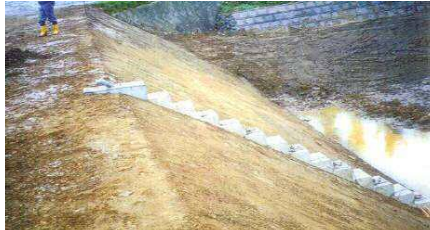
斜樋、底樋を復旧
