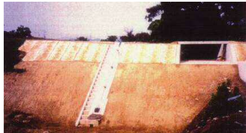
現場打ちコンクリートにより復旧
