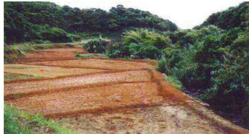
土砂排除及び表土搬入による復旧
