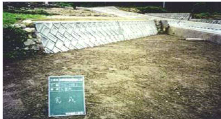
ブロックによる復旧
