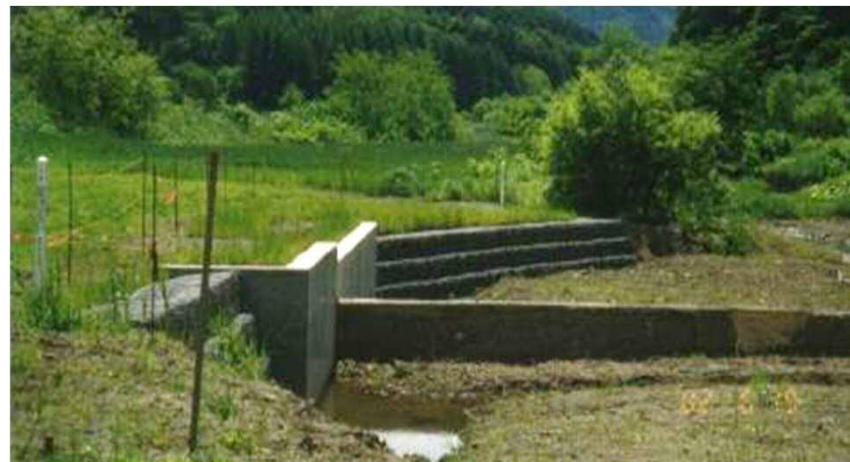
コンクリート擁壁及び取付護岸を復旧
