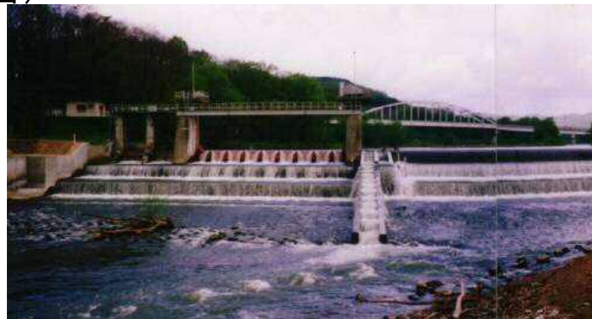
副堤及び魚道を設置し、機能を回復
