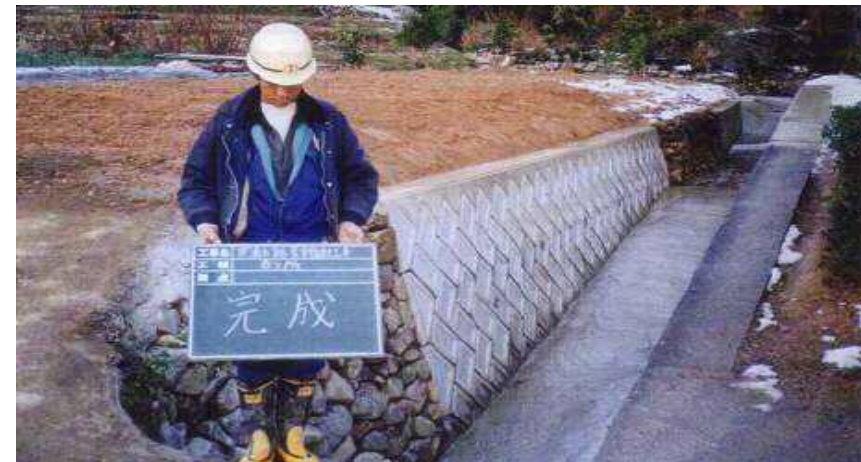
ブロック積で復旧
