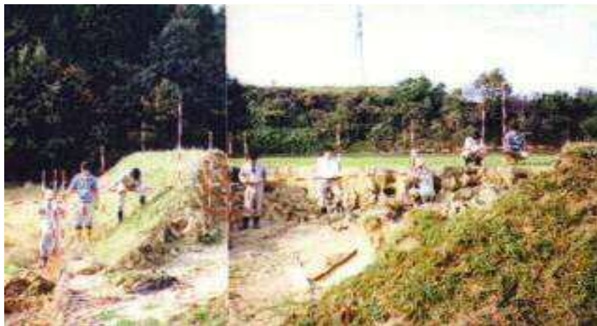
豪雨により畦畔崩壊
