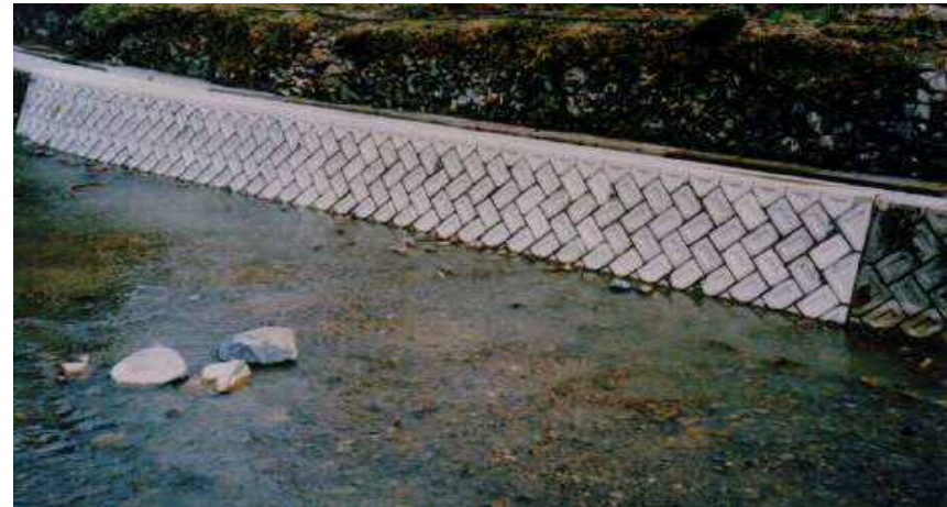
水路及びブロック積で復旧
