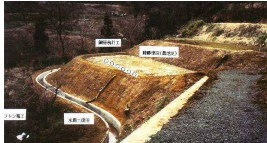
鋼管杭、フトン籠等の新設及び農地復旧
