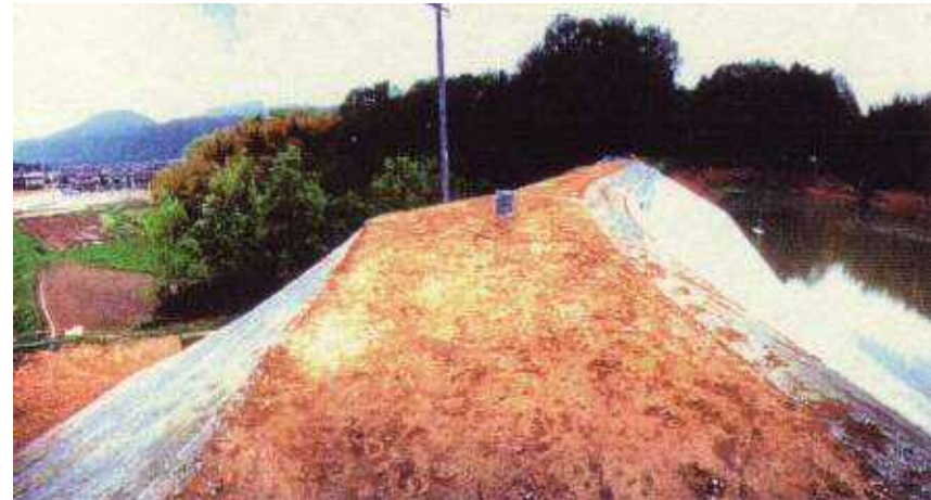
堤体を築直し、波徐護岸を新設
