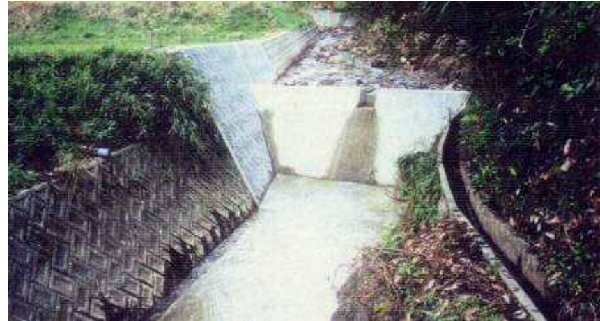
コンクリート堰にて復旧
