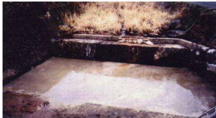
水叩き部をコンクリートにて復旧
