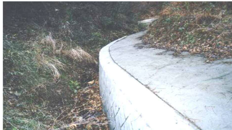
ブロック積による法留め工で復旧
