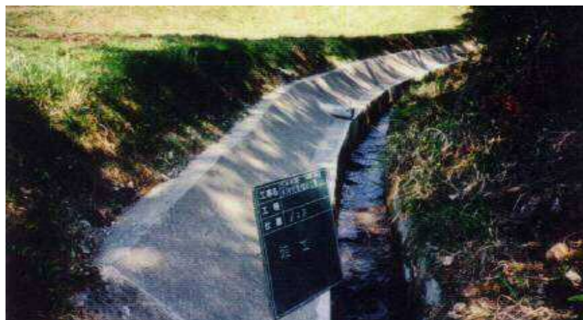
張りコンクリートで復旧
