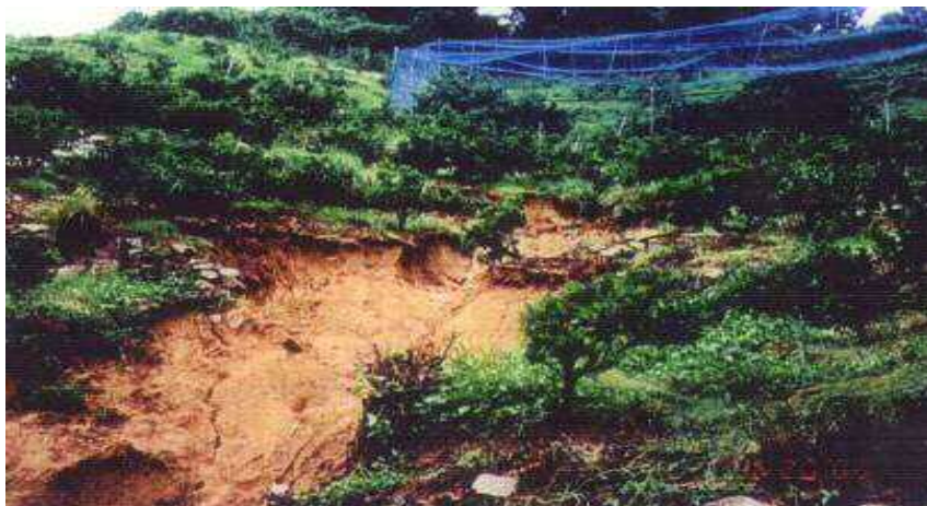
異常出水により農地が被災
