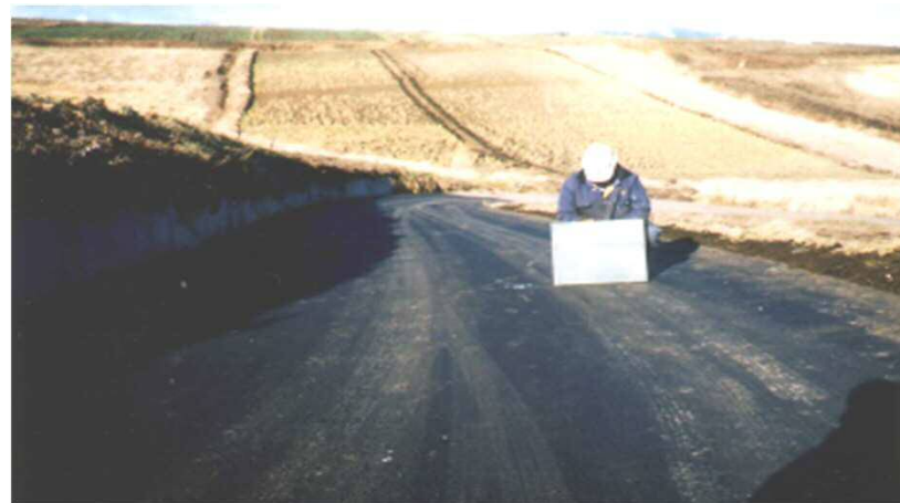
下層、上層路盤及びAS舗装の復旧
