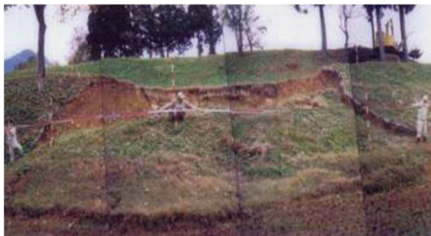
豪雨により畦畔崩壊
