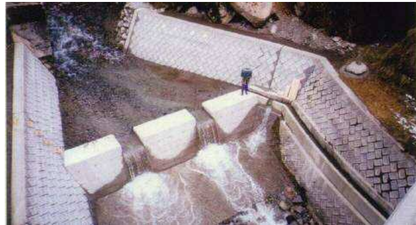
堤体、水叩き、護岸工を復旧
