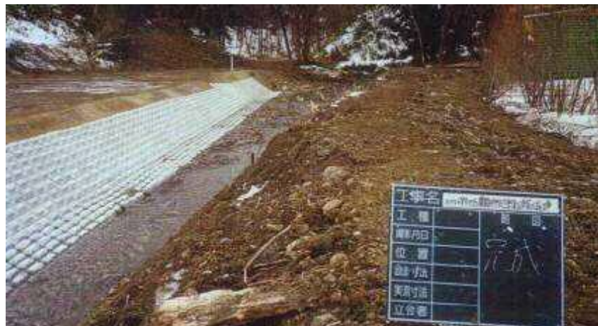
連結ブロックにより復旧
