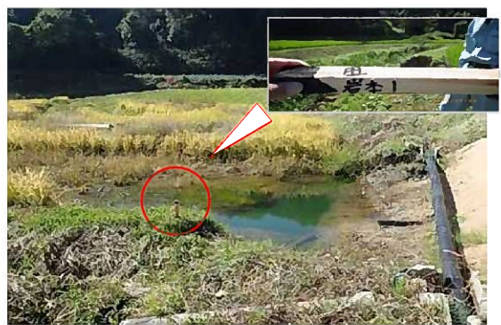
写真2 被害箇所起点の黒杭打設例
