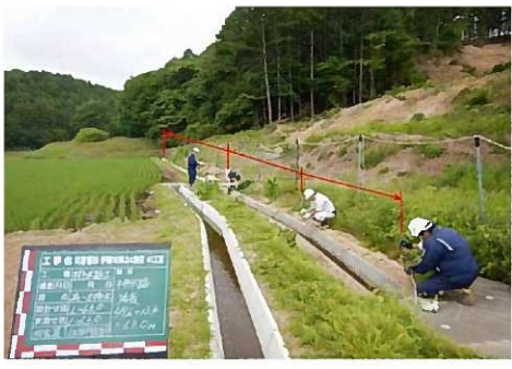
復旧後の水路延長の確認状況
