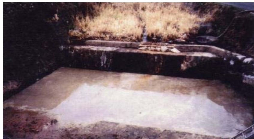
水叩き部をコンクリートにて復旧
