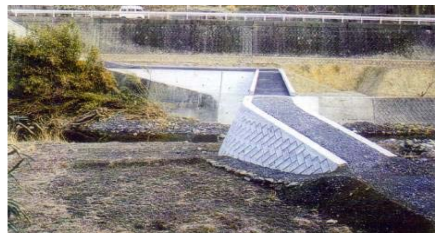
桁下高を上げて復旧
