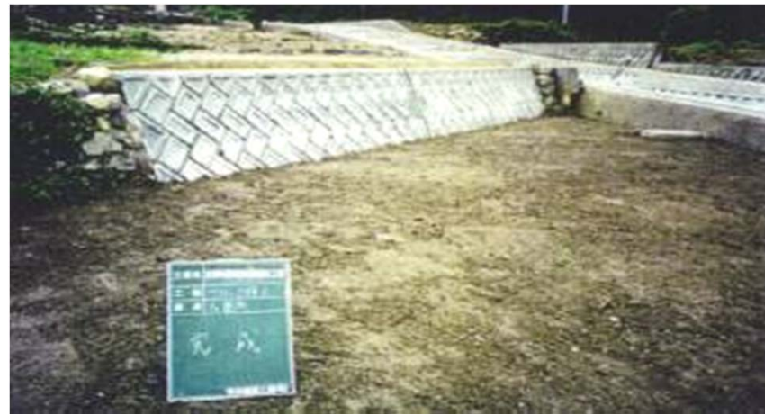
ブロックによる復旧
