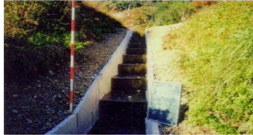
コンクリートフリューム水路により復旧
