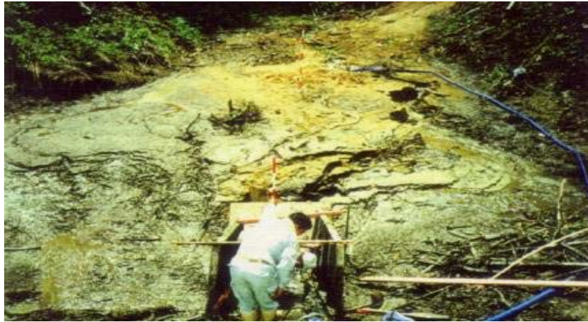
豪雨により土砂が流入
