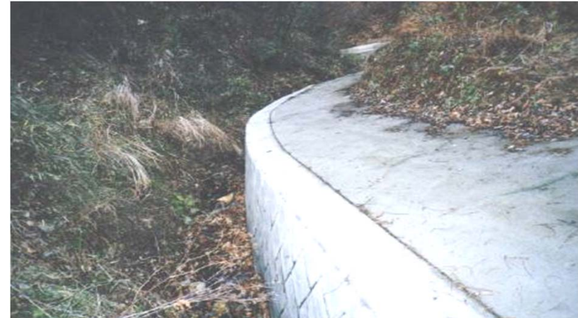
ブロック積による法留め工で復旧
