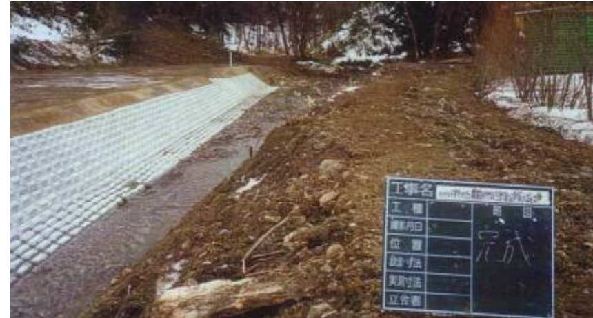
連結ブロックにより復旧
