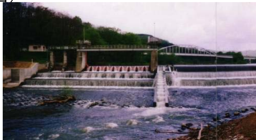
副堤及び魚道を設置し、機能を回復
