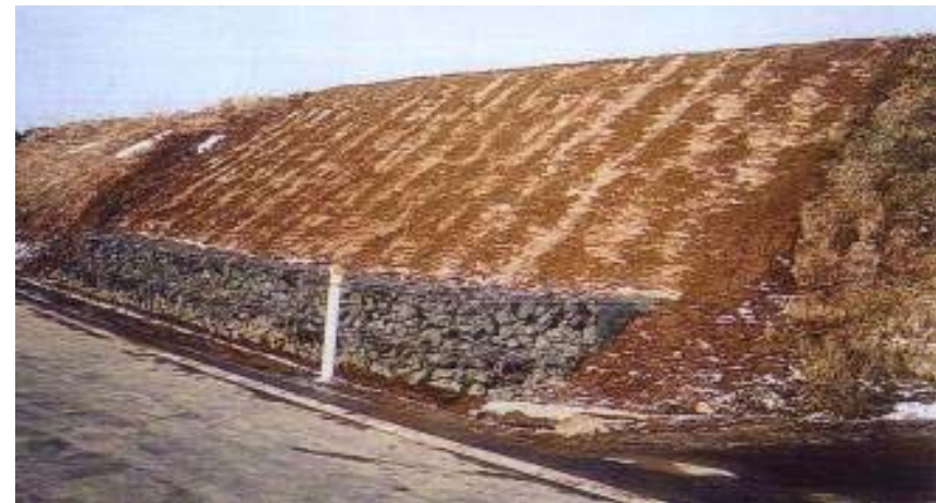
フン籠及び盛土により復旧
