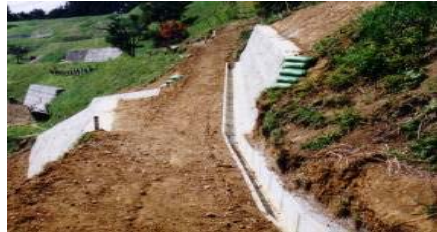
ブロック積による復旧
