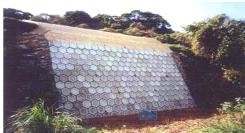
ブロックによる復旧
