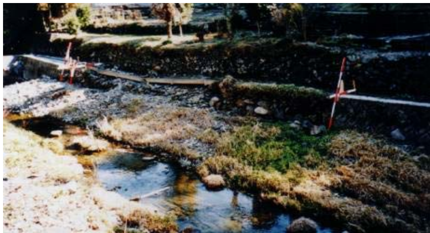
河川の氾濫により水路、護岸が被災
