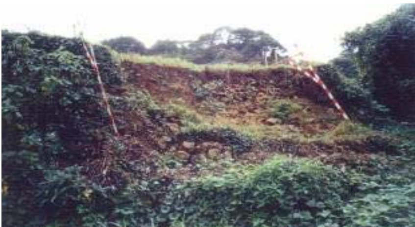
豪雨により畦畔崩壊
