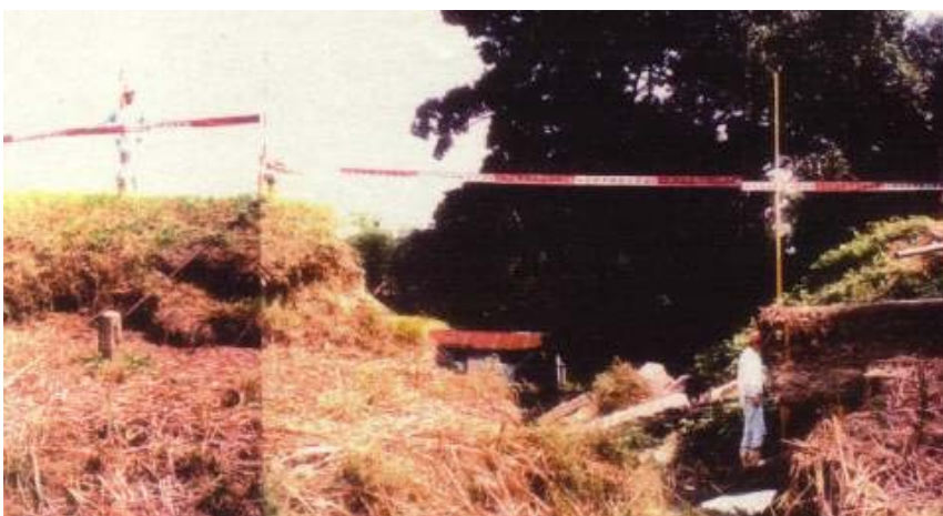
余水吐及び堤体の一部が決壊
