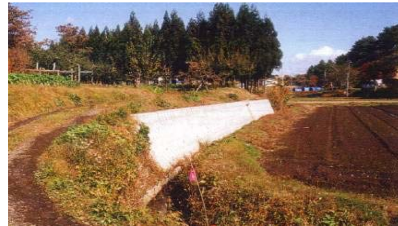
ブロック積による復旧
