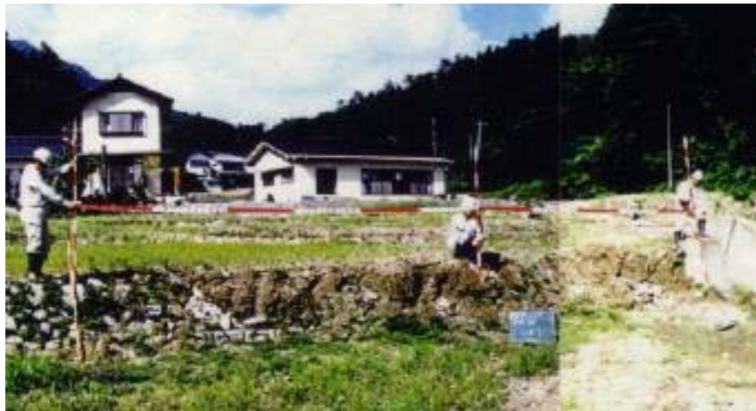
豪雨により石積畦畔崩壊
