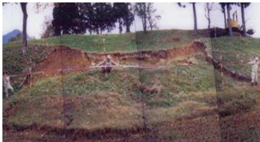
豪雨により畦畔崩壊
