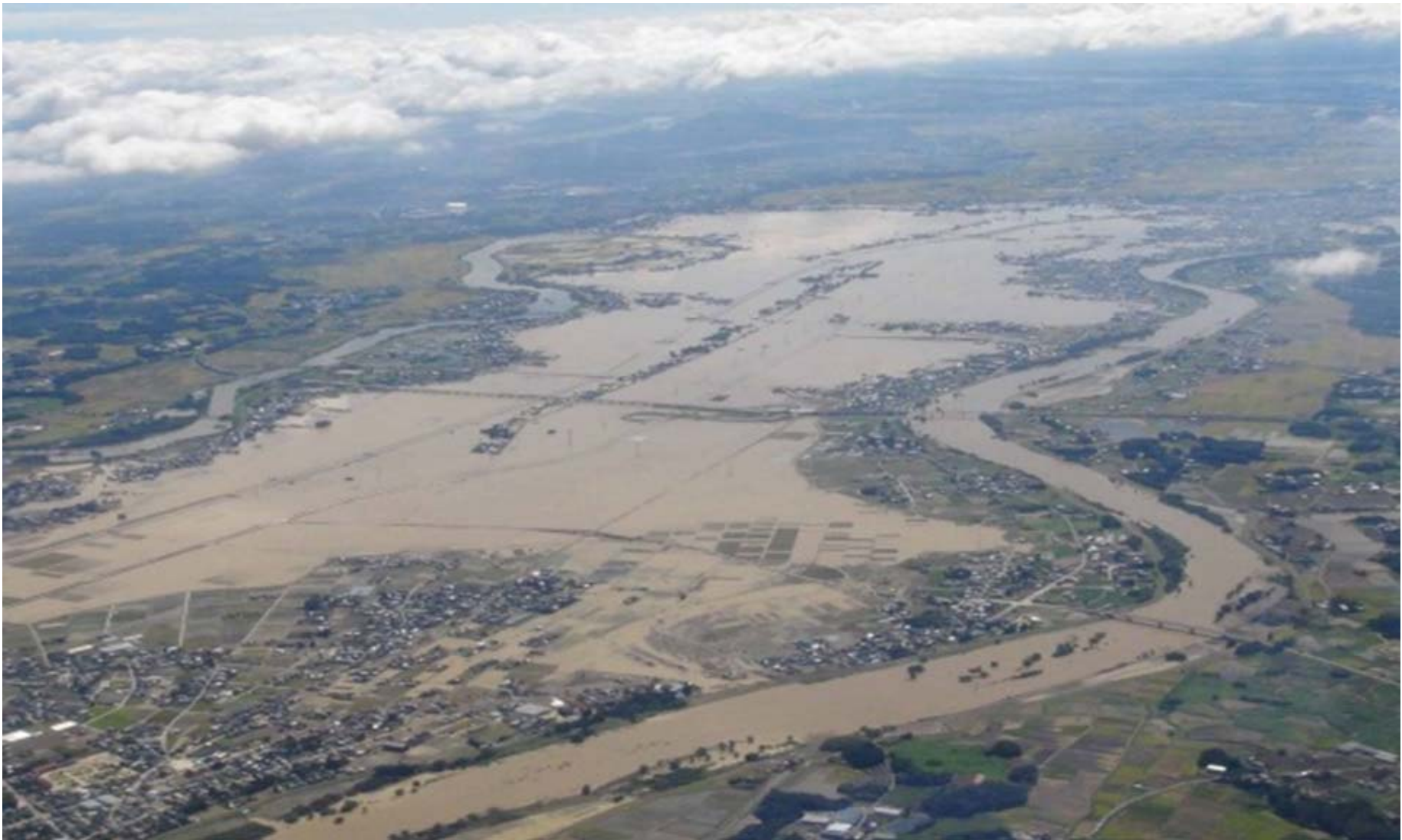
河川堤防決壊により広範囲で農地、農業用施設の被災(9月 茨城県常総市)
