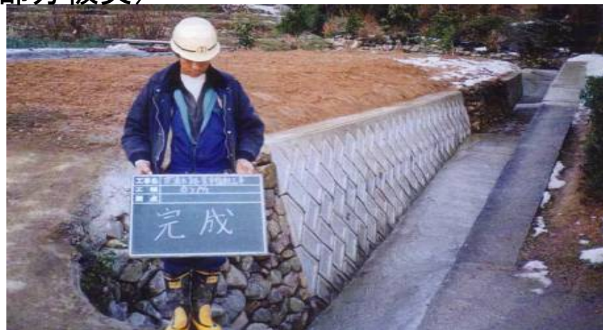
ブロック積で復旧
