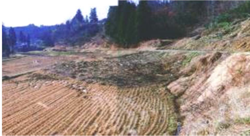
斜面崩落による土砂流入
