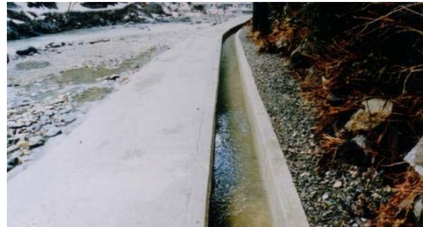
現場打ちコンクリートにより復旧
