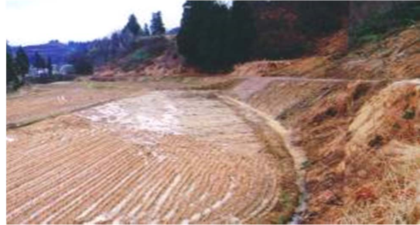
土砂排除による復旧
