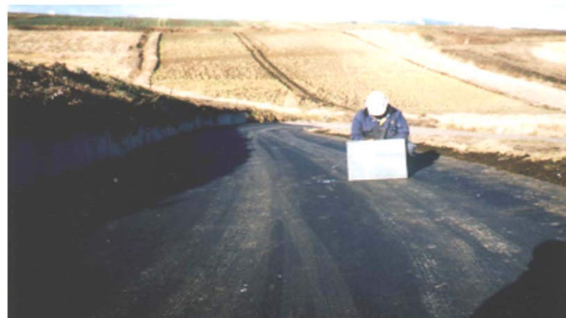
下層、上層路盤及びAS舗装の復旧
