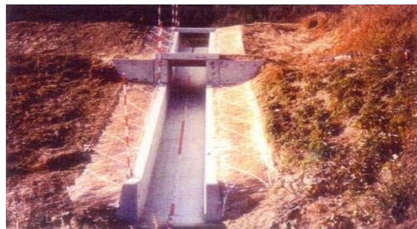
現場打ちにより復旧
