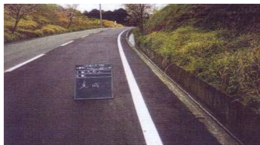
路盤及びAS舗装による復旧
