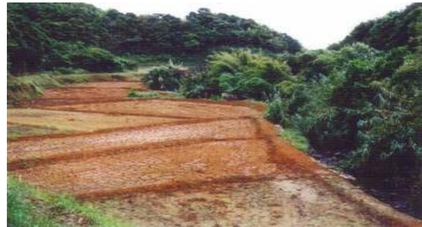
土砂排除及び表土搬入による復旧
