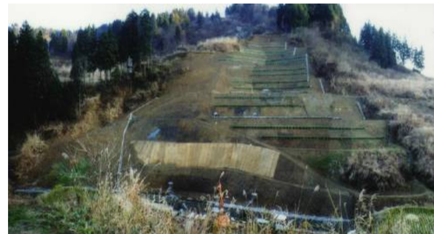
区画を変更しフトン籠、鋼管杭を新設
