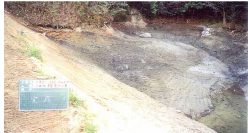
土砂及び流木排除より復旧
