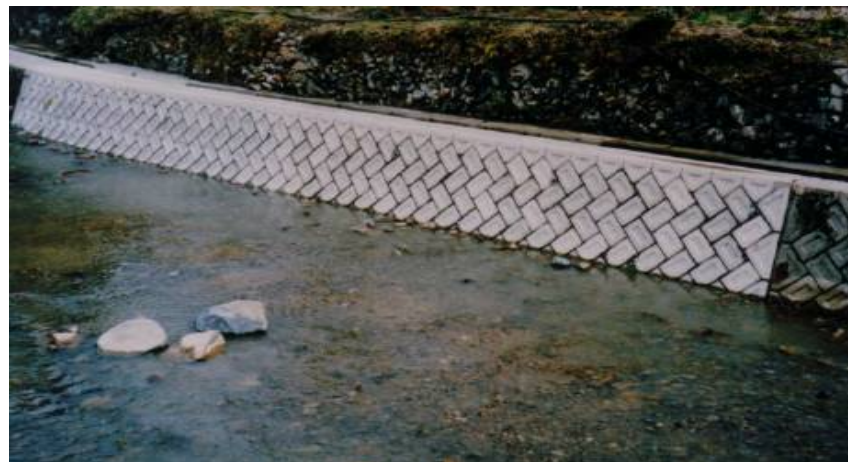
水路及びブロック積で復旧
