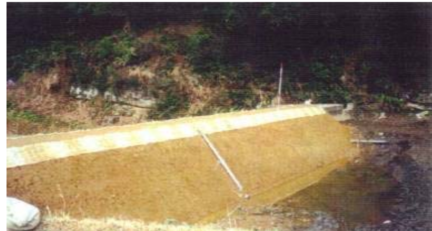
空洞部を開削し、前刃金工で復旧
