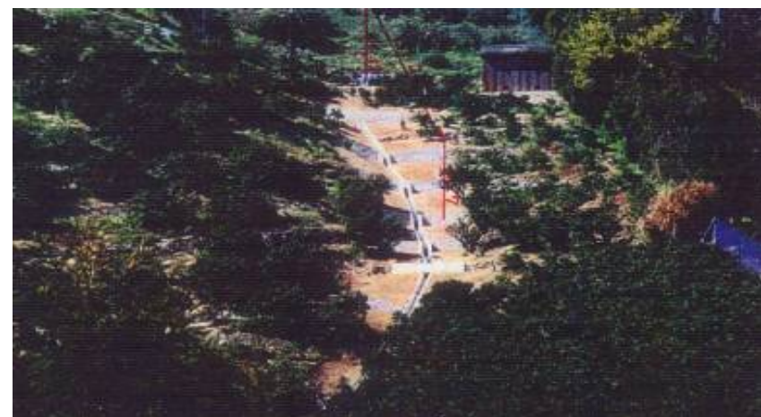
土止め、承水路工の新設
