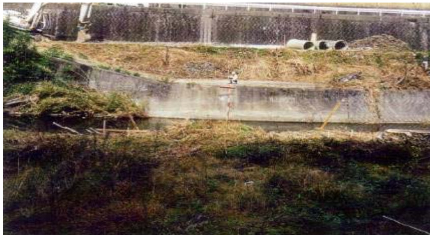
河川増水により鋼橋が流失
