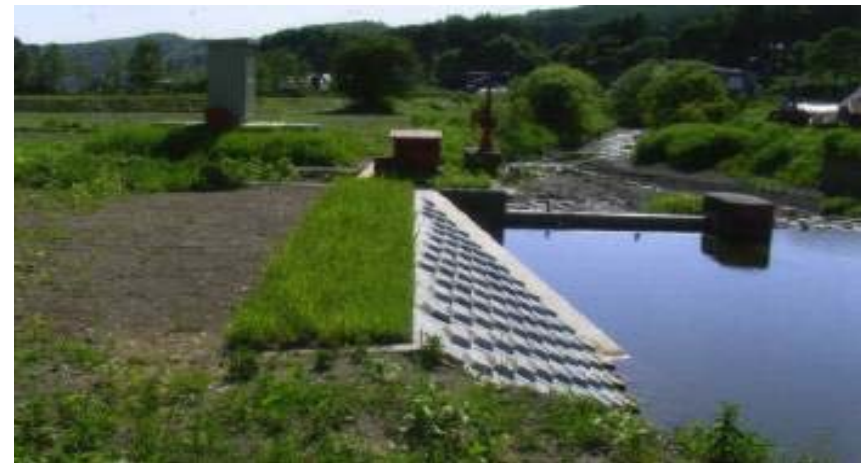
操作ユニットの復旧及び護岸の施工
