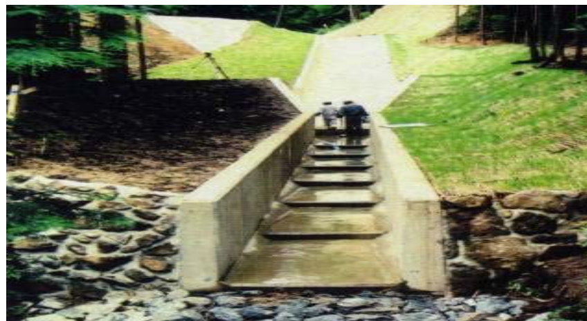
現場打ち水路、減勢工にて復旧
