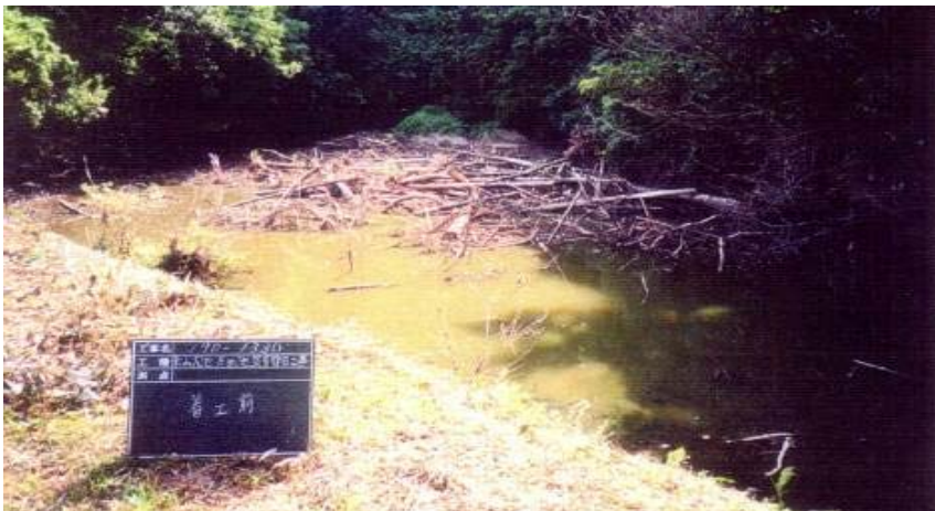
豪雨により土砂及び流木が流入
