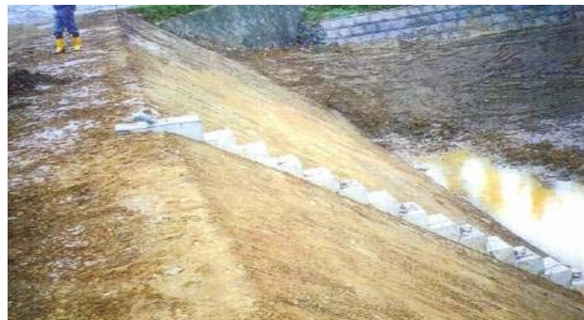
斜樋、底樋を復旧
