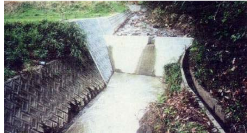
コンクリート堰にて復旧
