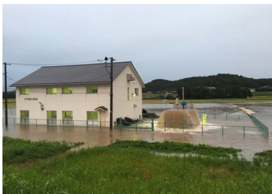
排水機場の被災(9月 宮城県大和町)
