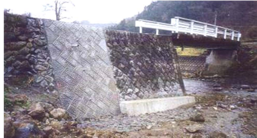
ブロック積による復旧
