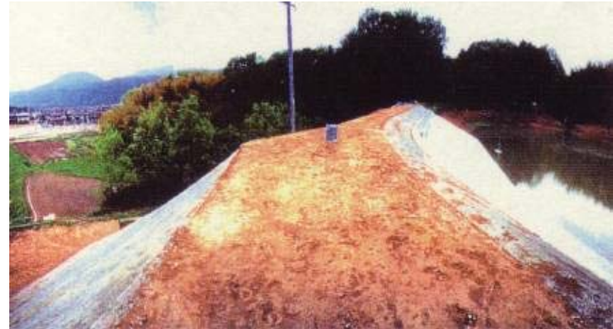
堤体を築直し、波徐護岸を新設
