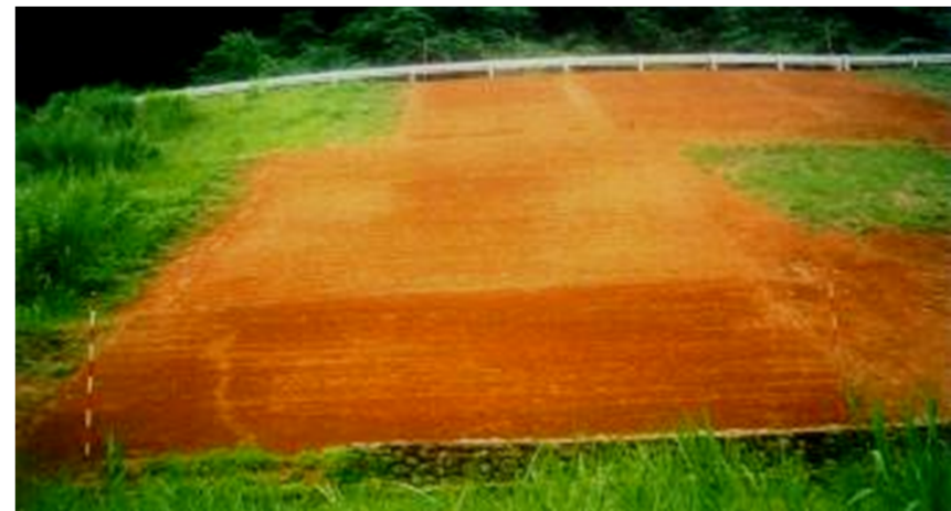
法面整形、筋芝工による復旧
