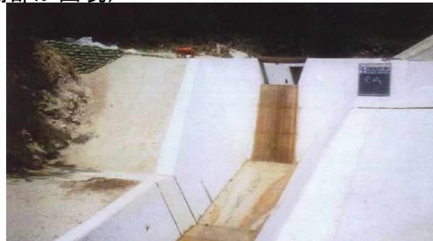
水位上昇に見合う護岸工等の復旧
