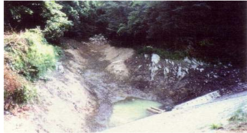
土砂排除により復旧
