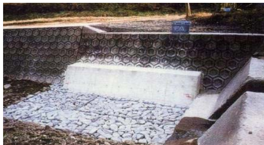
ブロック基礎を根継工にて復旧
