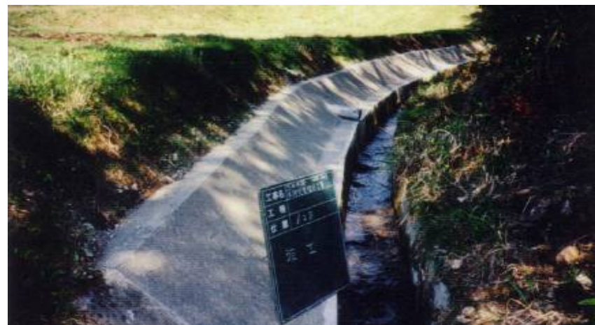
張りコンクリートで復旧
