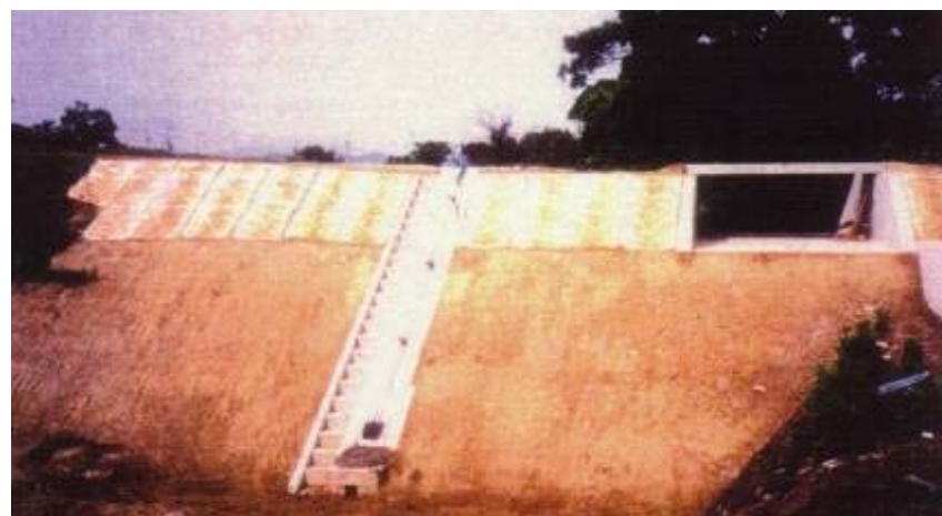
現場打ちコンクリートにより復旧
