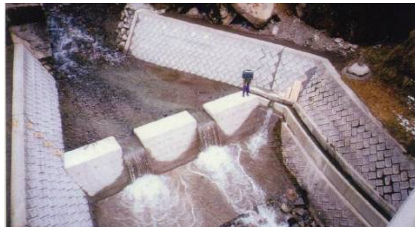
堤体、水叩き、護岸工を復旧
