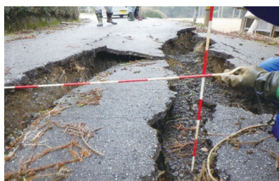
(管路沈下確認)
