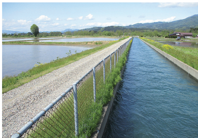
田沢疏水左岸幹線用水路
