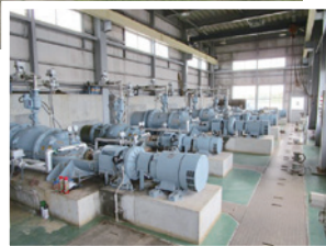
天王東排水機場
