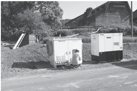
▲東北農政局による仮設ポンプの設置 (大仙市協和：白岩揚水機場)
