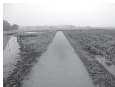
幹線水路（豪雨時）
