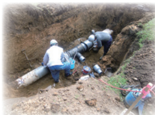
▲漏水箇所復旧工事の様子
