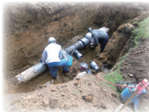
▲漏水箇所復旧工事の様子
