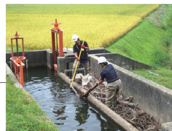
幹線用水路与惣右工門堰 分水工のゴミ除去作業状況
