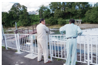
黒坂堰頭首工の流木撤去作業状況
