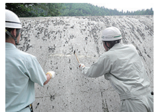
写真-4 コンクリートダム
