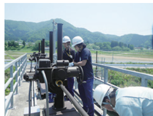
写真-3 土砂吐ゲート
