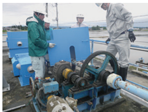
写真-2 土砂吐ゲート
