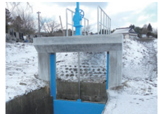
写真-8 水門の整備補修 ・門柱の補修とゲートの塗装をしました。
