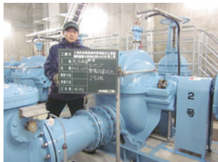
写真-5 揚水機場の整備補修 ・ポンプの塗装と部品交換をしました。
