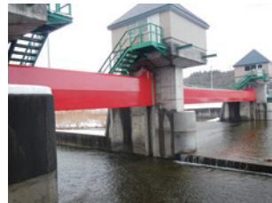
写真-7 頭首工の整備補修
