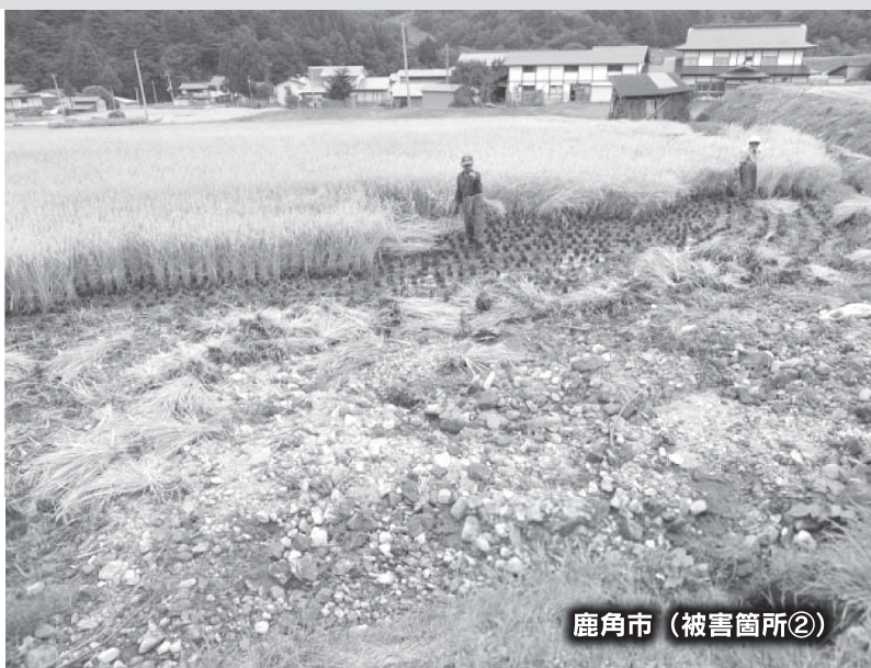
鹿角市（被害箇所①）
