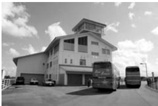
▲南部排水機場
