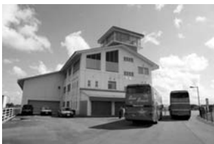
▲南部排水機場
