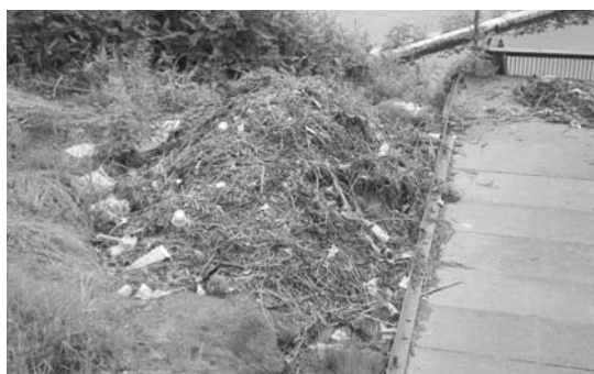
<T土地改良区が管理する取水施設>
