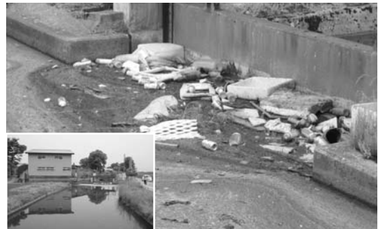
<Y 土地改良区が管理する大排水門>
