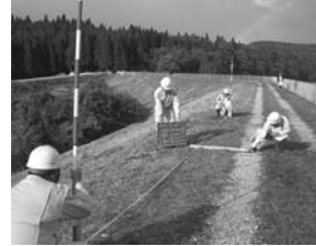
▲堤頂部の亀裂調査(訓練)
