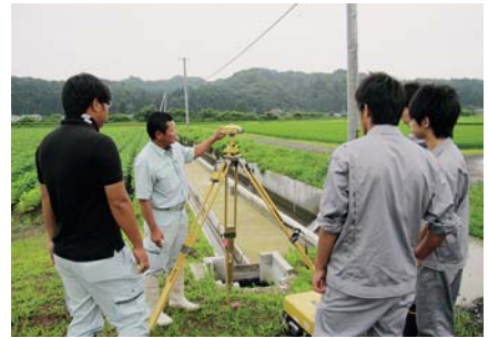
GPS測量機の説明
