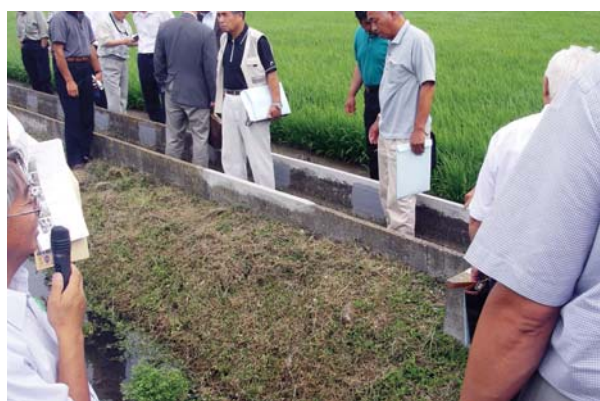
P P S工法による水路補修
