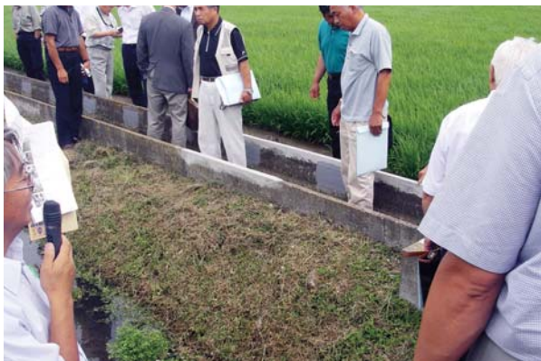
P P S工法による水路補修
