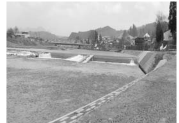
▲本災分工事完成（H21年3月） （関連部分は21年度施工予定）
