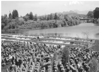
▲被災前頭首工
