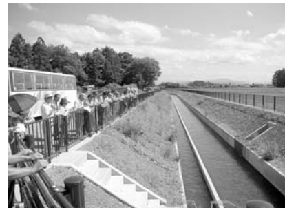
上流・下流部専用水路 [皆瀬2号幹線用水路]
