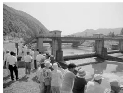
部分改修が予定されている成瀬頭首工
