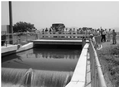
湯沢市岩崎地区へ分水する岩崎分木工 [皆瀬1号幹線用水路]
