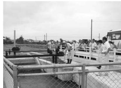
皆瀬川の川底をサイホンにより湯沢市岩崎地区へと 通水するM7サイホン[皆瀬7号幹線用水路]
