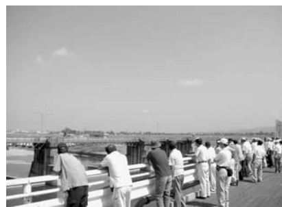
今年度に解体が予定されている旧皆瀬頭首工
