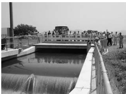
湯沢市岩崎地区へ分水する岩崎分土工 〔皆瀬1号幹線用水路〕
