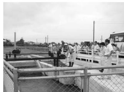
皆瀬川の川底をサイホンにより湯沢市岩崎地区へと 通水するM7サイホン〔皆瀬7号幹線用水路〕
