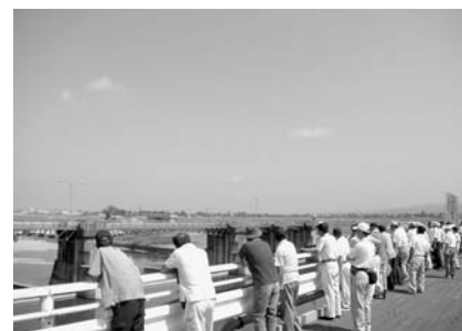
今年度に解体が予定されている旧皆瀬頭首工
