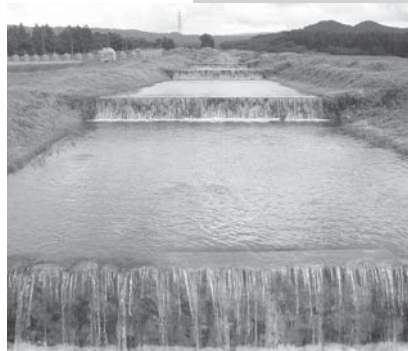
小滝温水路(にかほ市)
