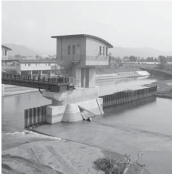
皆瀬頭首工(横手市)
