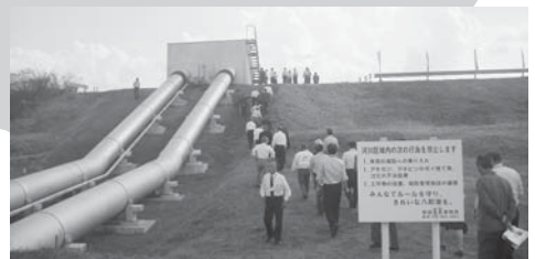
国営造成土地改良施設整備事業・F2取水口(大潟村)
