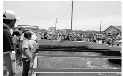
農業用サイフォンから取水した用水
