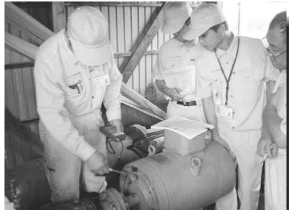
▲モーターの点検ポイント
