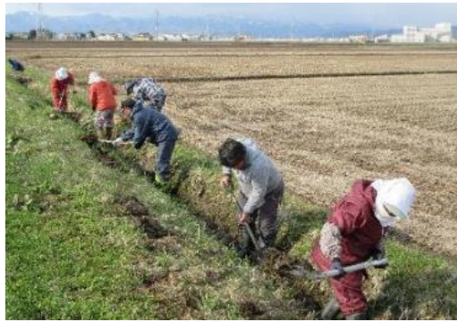
水路の泥上げ
