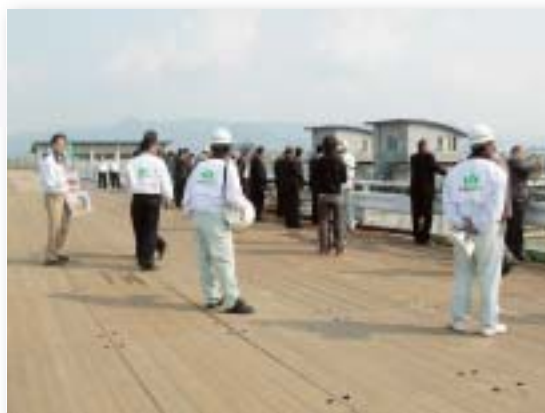
国営かんがい排水事業「皆瀬頭首工」
