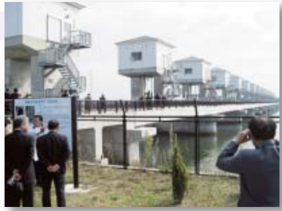
防潮水門（国営総合農地防災事業）
