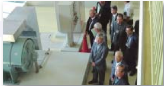
南部排水機場
