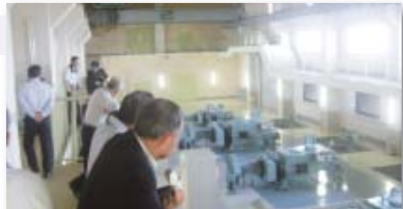
南部排水機場
