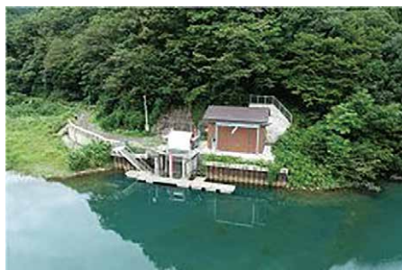
神代右岸取水口
