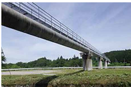
斉内川水管橋
